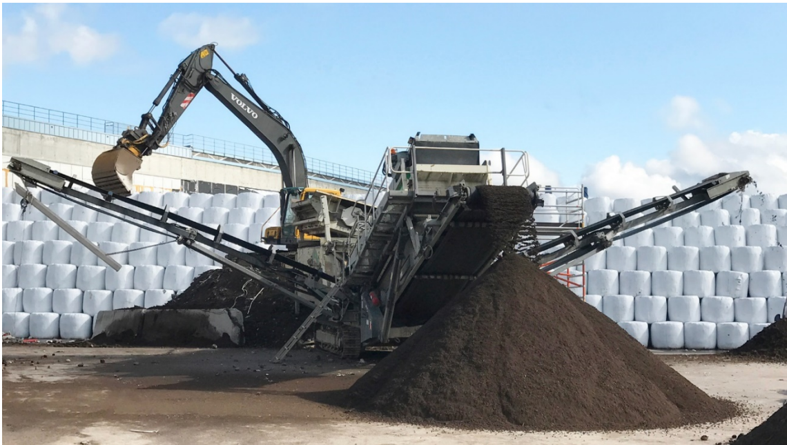
Kuva 6. Maa-ainesten seulontaa Ämmässuolla. Kuva: Sari Jurmo, HSY.
