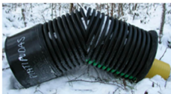
Supistin on asennettu kulmayhteen päähän
