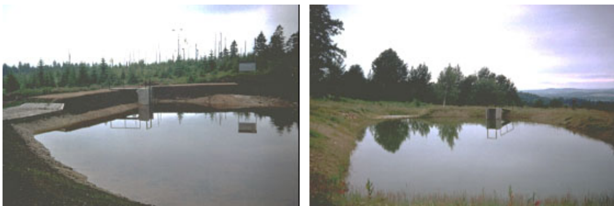
Kuva 30. Pieni patoallas vuoristoalueella Puolassa. Valokuvat Michał Wróbel.
