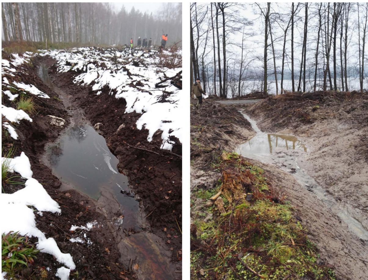
Kuva 4. Lietekuoppia kuivatusojissa Etelä-Ruotsissa. Valokuvat Eva Ring (vasen) ja Anja Lomander (oikea).
