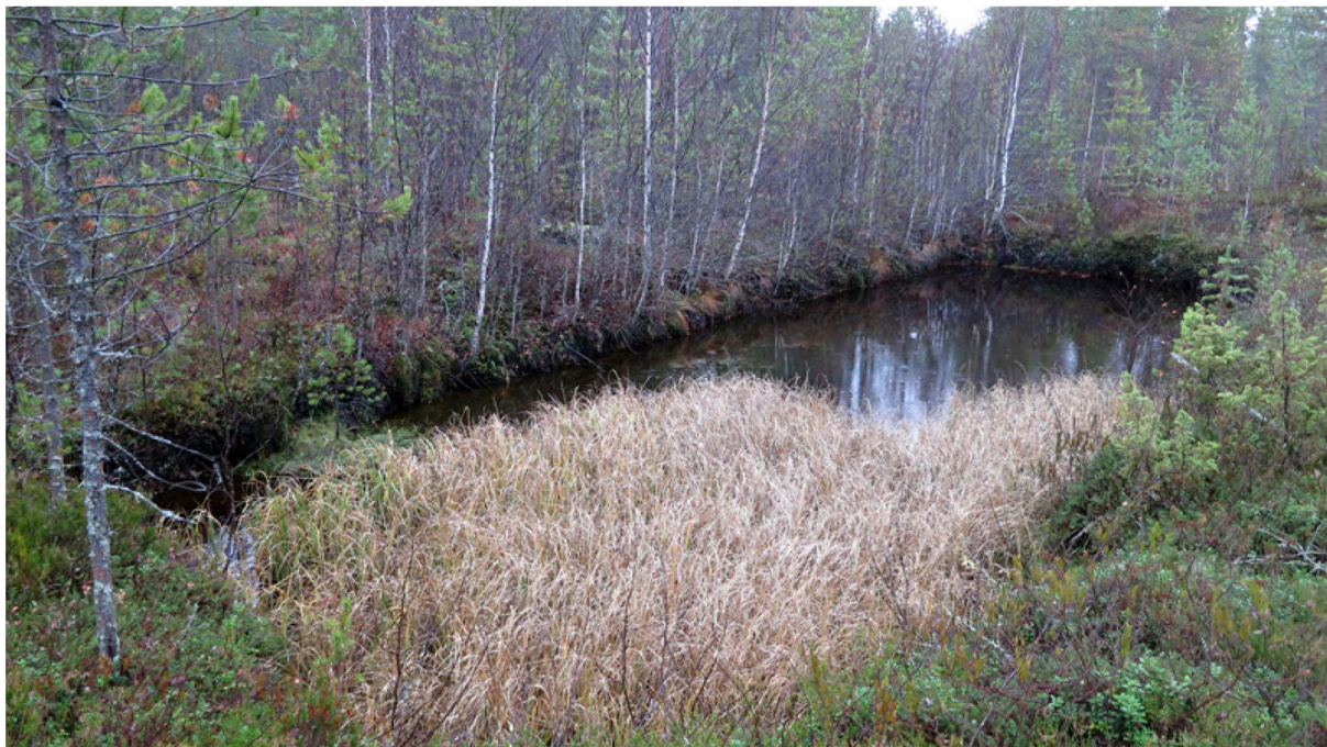
Kuva 21. Kaksikymmentä vuotta vanha laskeutusallas, jonka kasvillisuus on jo osin vallannut. Allas toimi kuten pieni kosteikko. Valokuva Tommi Tenhola.
