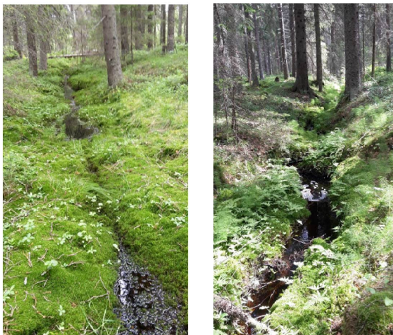
Kuva 3. Ruotsalainen esimerkki kuivatusojasta (vasemmalla) ja kokoojaojasta (oikealla) alueella, jossa ojitus on lisännyt puuston kasvua. Ojiin on jätetty kaivukatkoja ja niihin on kaivettu lietekuoppia 100–200 m välein. Valokuvat Bo Leijon.
