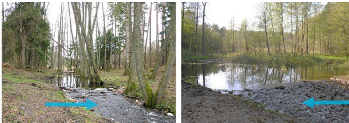
Kuva 26. Pohjapatoja, joissa on kalaportaat. Patojen kynnykset on rakennettu matalana puron koko leveydelle, jotta korkeusero puron pohjan kanssa olisi mahdollisimman pieni (FAO 2002). Valokuvat Andrzej Rys’.
