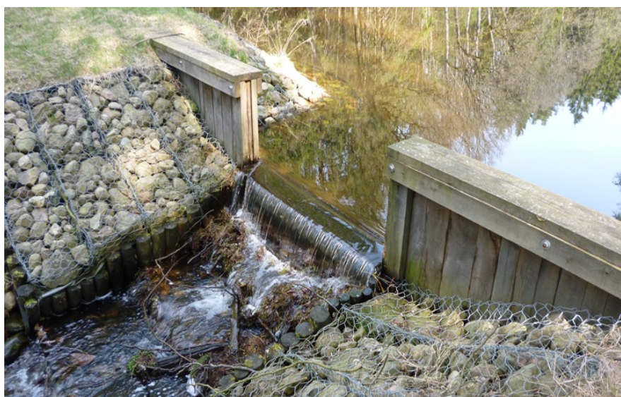
Kuva 29. Puroon rakennettu, sulkuluukulla varusteltu pato pohjavedenpinnan säätelyyn. Valokuva Michał Wróbel.
