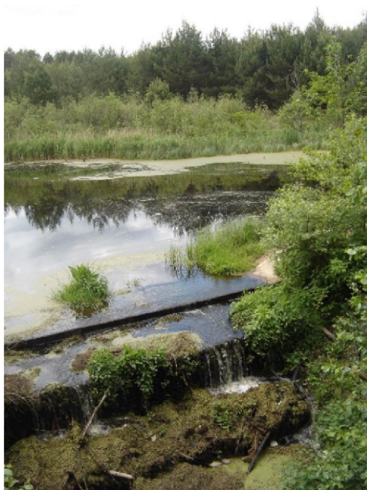
Kuva 32. Patoaltaan lasku-uomassa oleva pohjapato Puolassa. Valokuva Edward Pierzgalski.
