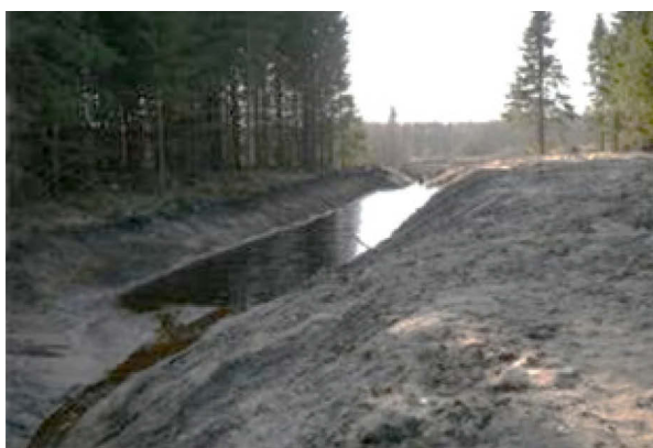
Kuva 17. Vasemmassa kuvassa uusi laskeutusallas Lativassa. Valokuva Zane Lībiete. Oikealla olevassa kuvassa 20 vuotta vanha laskeutusallas Keski-Suomessa. Valokuva Tommi Tenhola.
