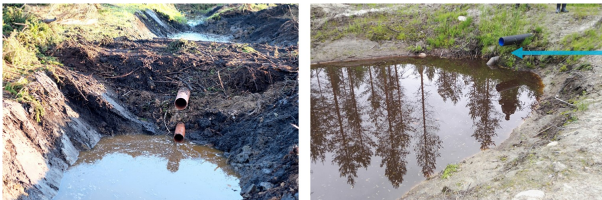
Kuva 8. Putkipatorakenteita kahdella WAMBAF-demonstraatioalueella. Vasemmassa kuvassa Keski-Ruotsissa sijaitsevalla Tobon alueella näkyy kaksi putkea. Valokuva Lars Högbom. Oikealla olevassa kuvassa Pohjois-Pohjanmaalla sijaitsevalla Vengasojan alueella alempi padottava putki on veden alla. Valokuva Leena Finér.
