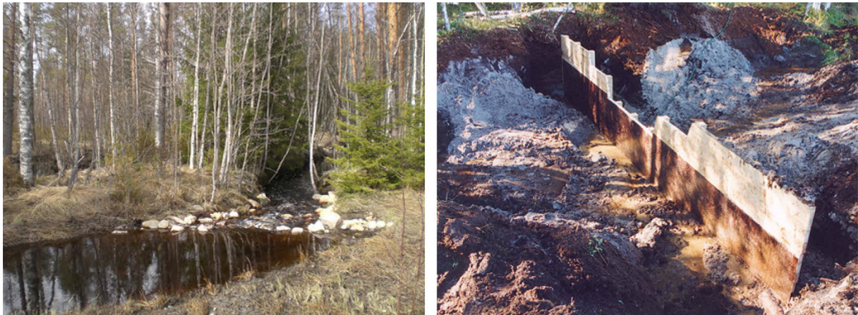
Kuva 6. Vasemmassa kuvassa on toiminnassa oleva pohjapato. Kuva Leena Finér. Oikealla olevassa kuvassa on rakenteilla oleva tukiseinämä, joka on sijoitettu ojan poikki keskelle pohjapatoa missä veden virtausnopeuden on arvioitu olevan suuri. Kuva Matti Seppälä.
