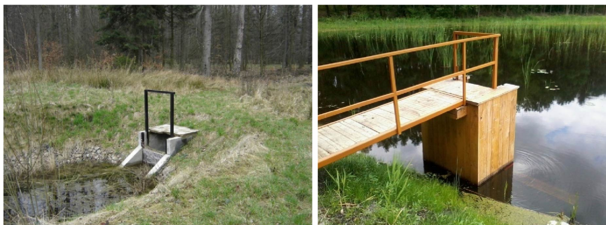
Kuva 33. Hydraulisia rakenteita, jotka kontrolloivat veden virtausta patoaltaasta. Valokuvat Michał Wróbel.
