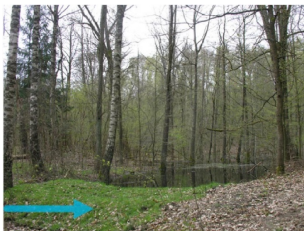
Kuva 27. Puron poikki kivistä ja puumateriaalista rakennettu pato, joka on peitetty maa-aineksella. Valokuva Andrzej Rys’.
