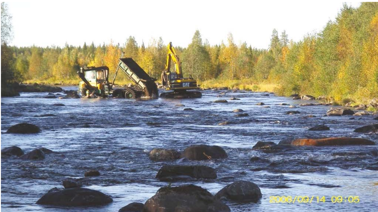
Kuva 12. Ala-Korpuankosken kunnostusta. Kuva: Eero Moilanen.
