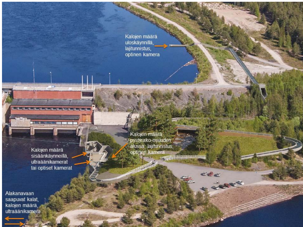
Kuva 9. Iijoen Raasakan voimalaitokselle suunnitellun kalatien ja kalojen seurantajärjestelmien havainnekuva. Kuva: Iijoen otva -hanke, Pohjois-Pohjanmaan liitto
