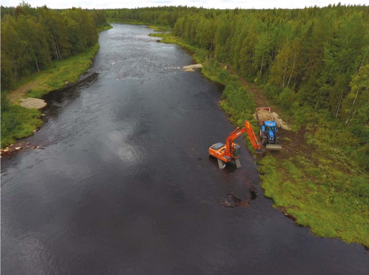
Kuva 13. Simojoen Mötykosken kunnostustyöt alkamassa kesällä 2016. Kuva: Ari Huusko.
