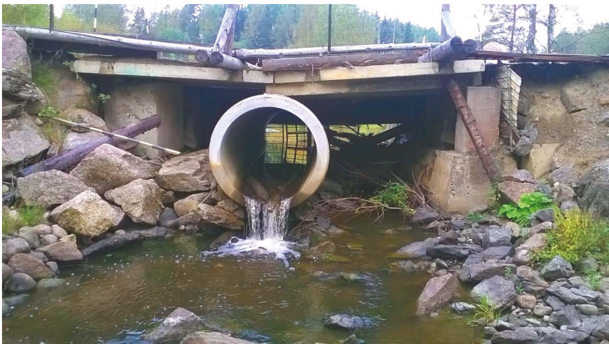
Kuva 2. Mustajoki Venäjän rajavalvontalinjan kohdalla. Esteaita patoaa jokea erityisesti alivirtaamakausiin. Kuva: Pekka Vähänäkki.
