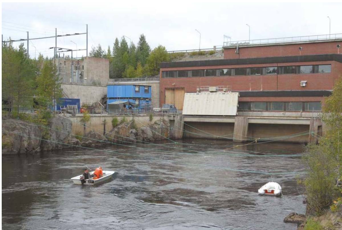
Kuva 5. Kalatiesuunnittelun tueksi selvitettiin Iijoen vesivoimalaitosten alakanavissa lohien vaelluskäyttäytymistä ja elinympäristönvalintaa radiotelemetriaseurannoilla ja kaikuluotauksilla sekä alakanavien virtausolosuhteita 3D-mallinnuksilla. Kuvassa Maalismaan voimalaitos ja sen alakanava. Kuva: Panu Orell.
