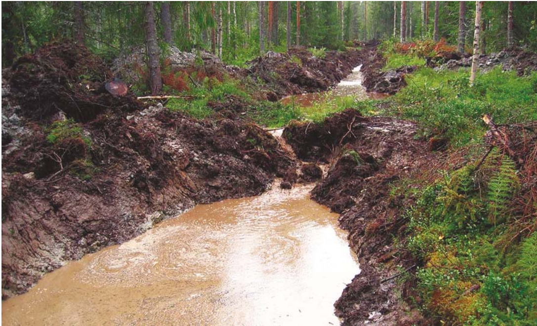
Kuva 15. Metsäojituksen yhteydessä toteutetut vesiensuojelutoimenpiteet pidättivät karkeampaa kiintoainetta riittävän hyvin. Valuma-alueen muokkaamisesta johtuvat virtaaman vaihtelut voivat peittää alleen metsäojituksen aiheuttamat paikalliset vaikutukset Kuva: Pauliina Louhi.
