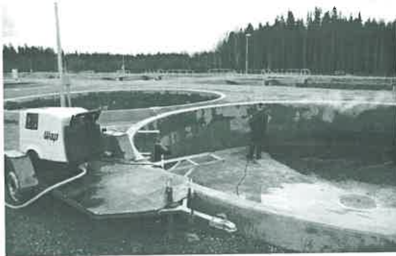
Betonialtaiden puhdistustyö, Kainuun kalantutkimus ja -vesiviljely. Kuva. Risto Kannel.
