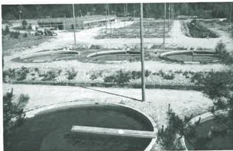
Ø 9 m betonialtaita ulkoalueella, Taivalkosken riistan- ja kalantutkimus. Kuva. Matti Karjalainen.
