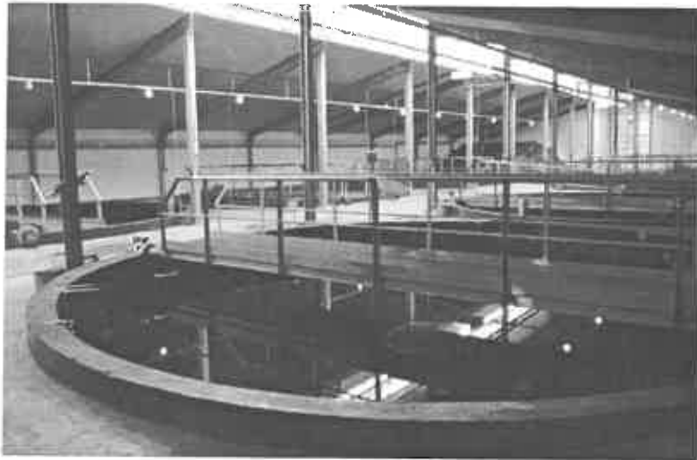
Kuva. Emokalahalli, Ø 8 m betonialtaita, Tornionjoen kalanviljelylaitos.
