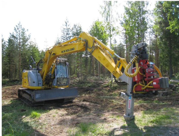
Kuva 4. Kaivukoneharvesteri odottamassa lavettikuljetusta. Hakkulaite on sidottu kuljetusta varten Kesla Xtender 15H jatkoapuomiin. Kuva Metla/Juha Laitila.
