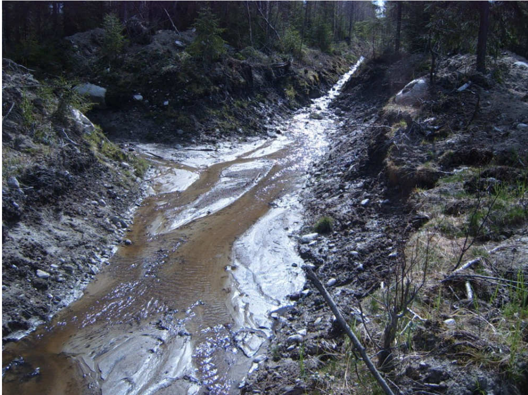
Kuva 3. Laskeutusallas on kaivettu jyrkkää rinnettä laskevan ojan loppupäähän. Tällöin on vaarana kiintoaineen virtaamisen vähentämisen sijaan entistä suurempi virtaaminen alapuolisiin vesistöihin. Kuva: Timo Silver.
