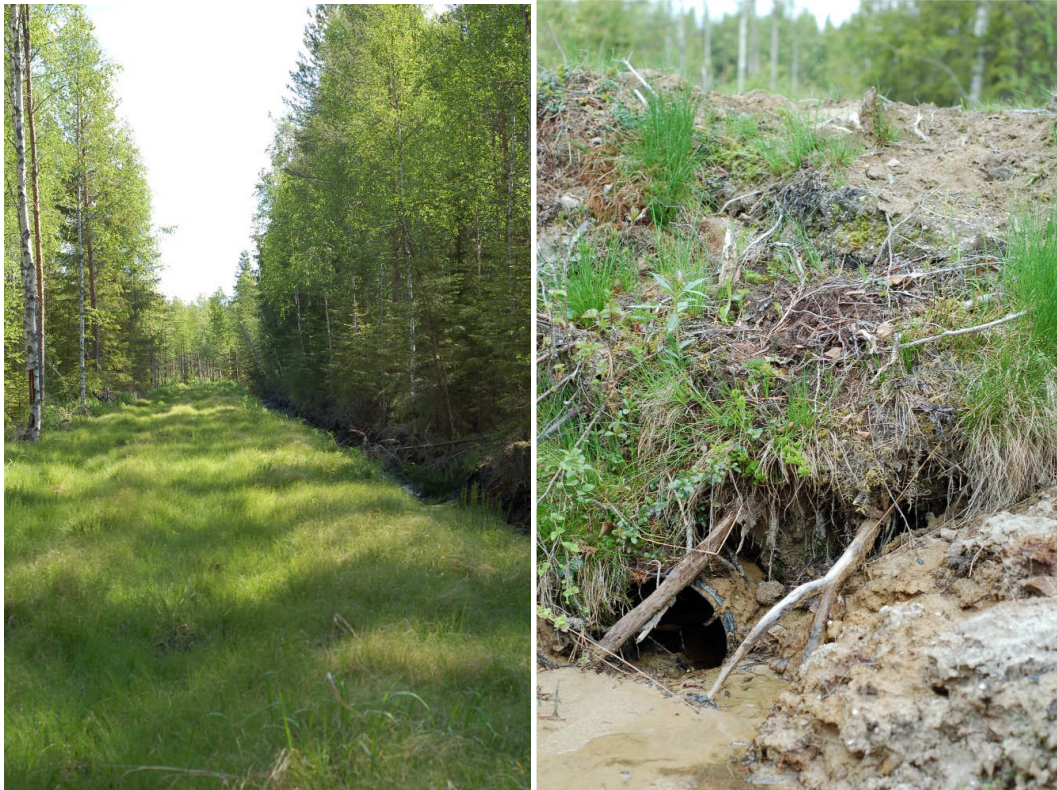
Kuva 4 (vasen) ja 5 (oikea). Vasen kuva: Piennarteistä on hyötyä turvemaaleimikon puunkorjuussa. Oikea kuva: Liian pienet ojarummut voivat tukkeutua jo muutama vuosi kunnostusojituksen jälkeen. Kuvat: Sanna Kittamaa.
