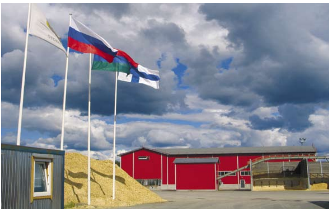
Kuva 4. Stora Enson sahalaitos Impilahdella Karjalan tasavallassa (kuva Stora Enso Oy).
