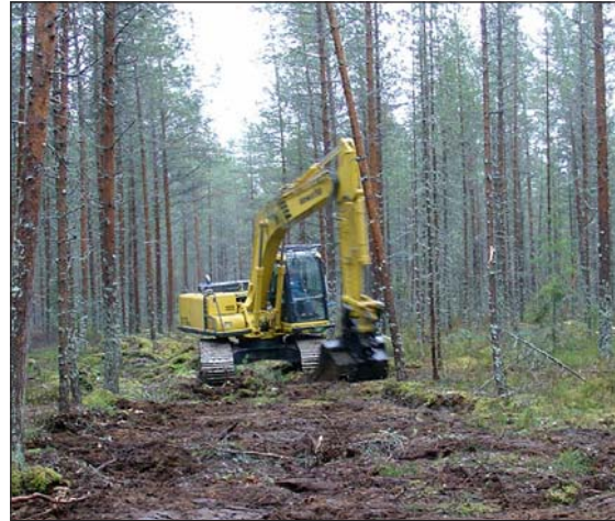
Kuva 16. Sarkaojan puupato ja valtaojan koneellinen täyttö. Kuvat: Metla/Kalle Eerikäinen.
