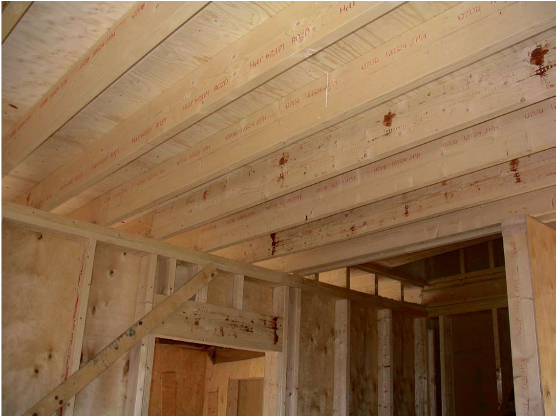
Kuva 9. Platform-järjestelmällä toteutettu Suomi-talo on helppo pystyttää henkilövoimin. (Kuva: PL-Rakennuttaja/Pertti Laine)
