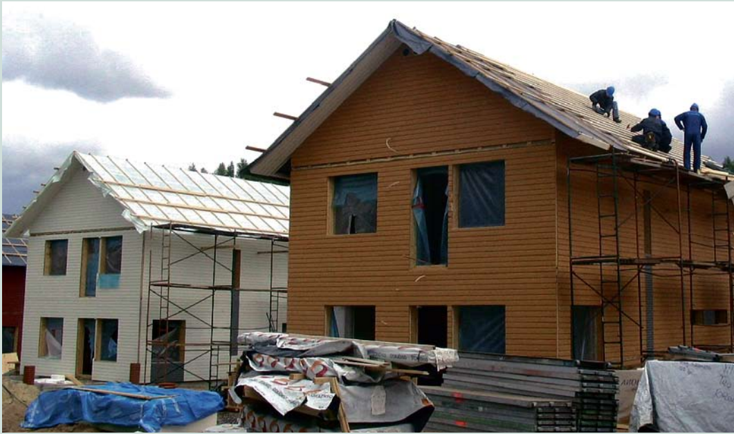
Kuva 3. YIT:n rakenteilla olevia suurelementtitaloja Kelton asuntomessualueella kesäkuussa 2008. (Kuva: PL-Rakennuttaja/Pertti Laine)
