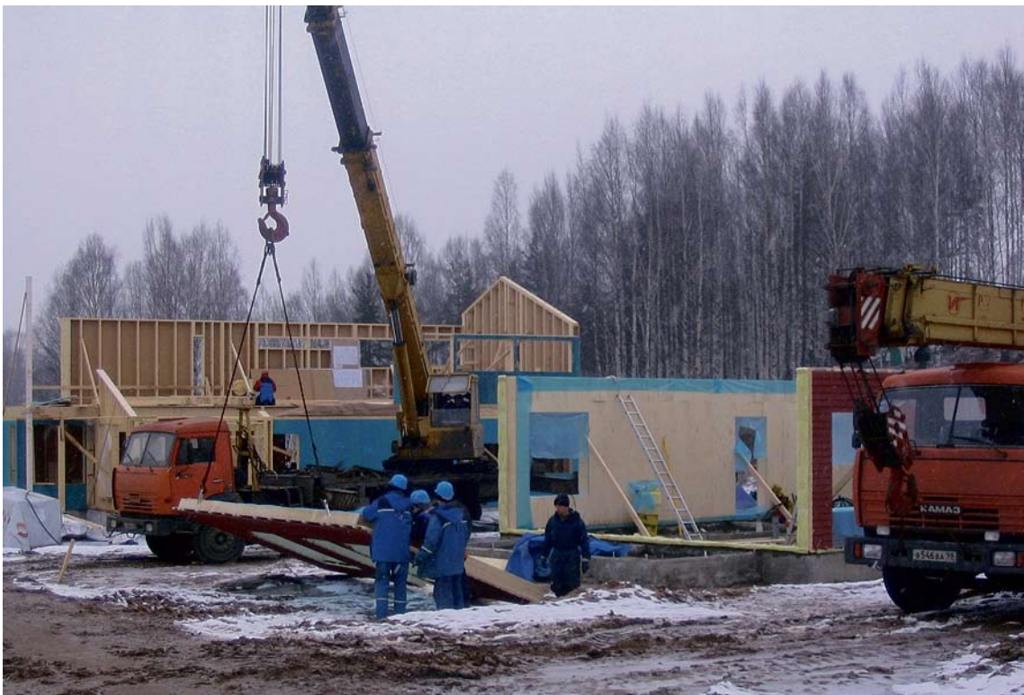
Kuva 8. Elementtirakentaminen vaatii riittävää nostokalustoa. (Kuva: PL-Rakennuttaja/Pertti Laine)
