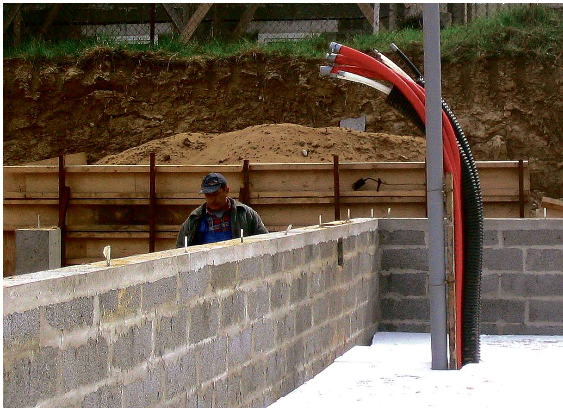
Kuva 13. Rakentaja joutuu usein itse kokonaan vastaamaan verkostojen vetämisestä rakentamisalueelle. (Kuva: PL-Rakennuttaja/Pertti Laine)
