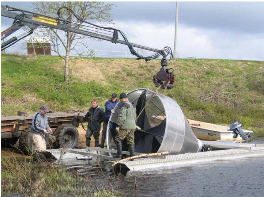
Kuva 5. Smolttiruuvien kokoaminen käynnissä Simojoen rannassa.
