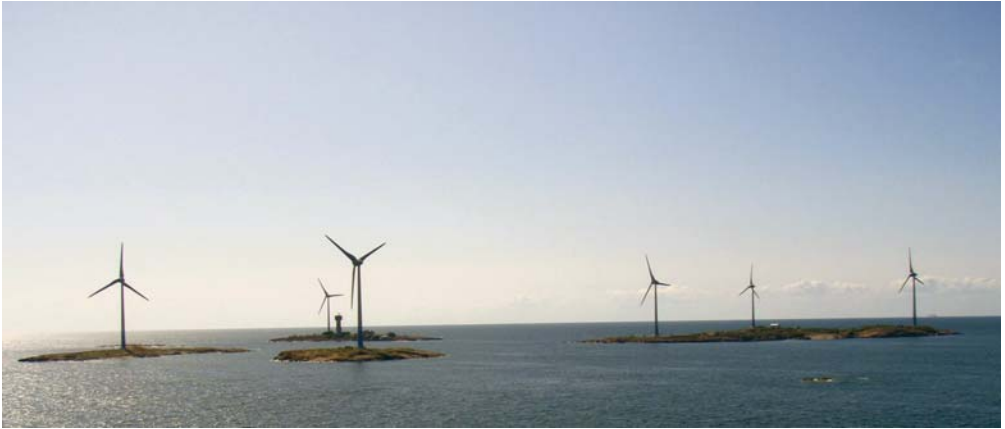
Kuva 1. Luodoille pystytetyt tuulivoimalat eivät vaadi pohjan muokkausta. Kuva S. Auvinen.
