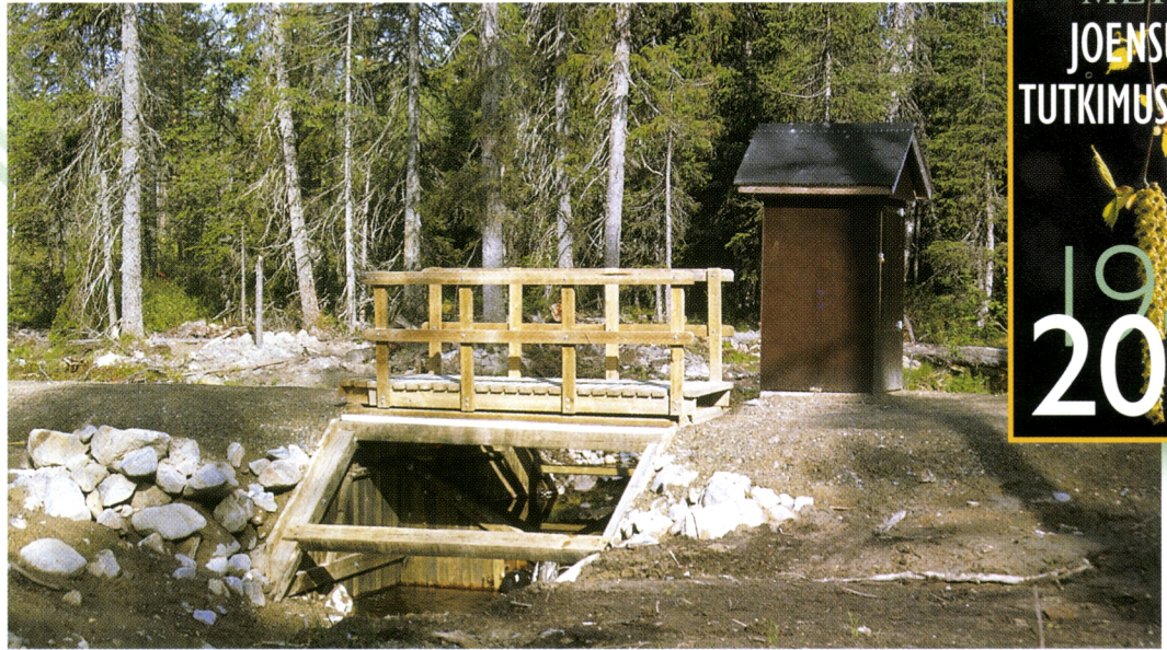
Tutkimuspato on rakennettu valumaveden laadun ja määrän seurantaan varten. Valuma-alueella tehdyssä avohakkuussa purovarsi on jätetty hakkaamattomaksi suojavyöhykkeeksi. Kuva: Erkki Oksanen.
