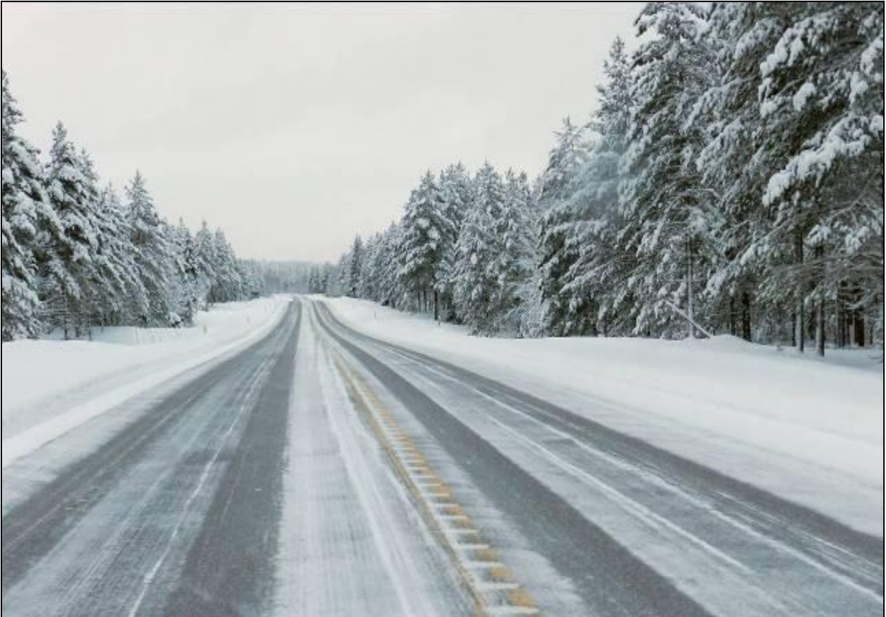
Kuva 44. Valtatietä n:o 20 välillä Pudasjärvi-Taivalkoski suolataan runsaasti syksyllä ja alkutalvella. Tien keskelle jyrstetty turvaaura kerää runsaasti suolavettä. Suola houkuttelee poroja tielle ja lisää suuresti porokolaririskiä. Kuva Mauri Nieminen.
