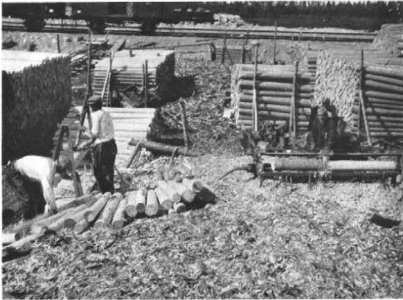
Kuva 5. Yleiskuva kuorimis- ja jälkikuorintakoneesta. Fig. 5. General view of barking and after-barking machines.
