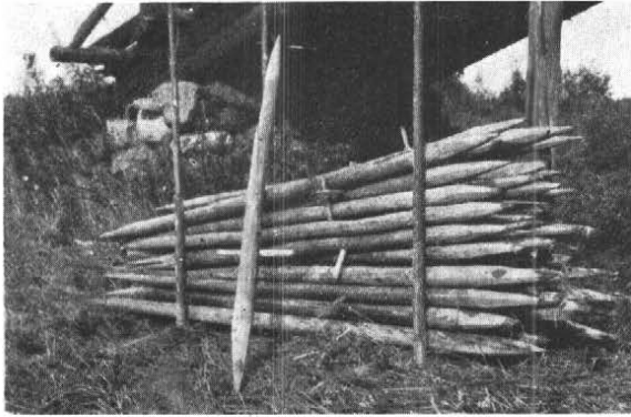
Kuva 29. Heinäseipäitä. Pituus 2.54 m. Paksuus keskeltä 6.6 cm. Kiintomitta 0.4649 k.-m 3 . Pinomitta 0.9815 p.-m 3 . Tiheys 0.4737. — Abb. 29. Heupfähle. Länge 2.54 m. Mittensstärke 6.6 cm. Festmass 0.4649 Fm. Raummass 0.9815 Rm. Reduktionsfaktor 0.4737.
