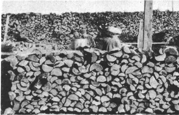
Kuva 13. 1-metrisiä halkaistuja havupuuhalloja. Keskiläpimitta 14,0 cm. Kiintomitta 1,8930 k.-m 3 . Pinomitta 2,8350 p.-m 3 . Tiheys 0,6677. — Abb. 13. 1 m langes, gespaltenes Nadelbrennholz. Mitteldurchm. 14,0 cm. Festmass 1,8930 Fm. Raummass 2,8350 Rm. Reduktionsfaktor 0,6677.
