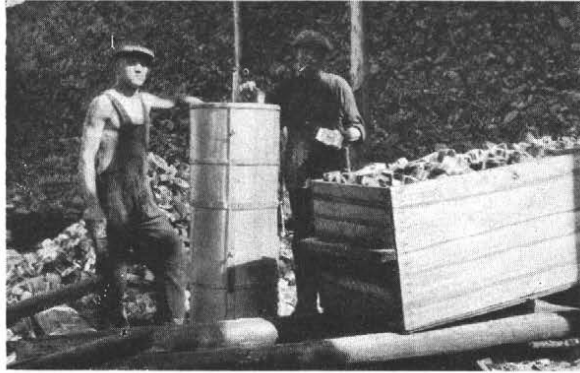
Kuva 25. Laatikko, jossa kiekkokasan pinomitta määrättiin. — Abb. 25. Kasten, in dem der Raumgehalt der Scheibenbestimmt wurde.
