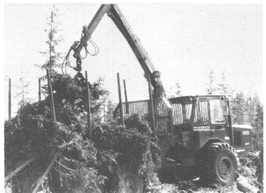
Kuva 9. Oksaraaka-aineen kuljetusta kuormatraktorilla. Picture 9. Transportation of branch raw material with a forwarder.
