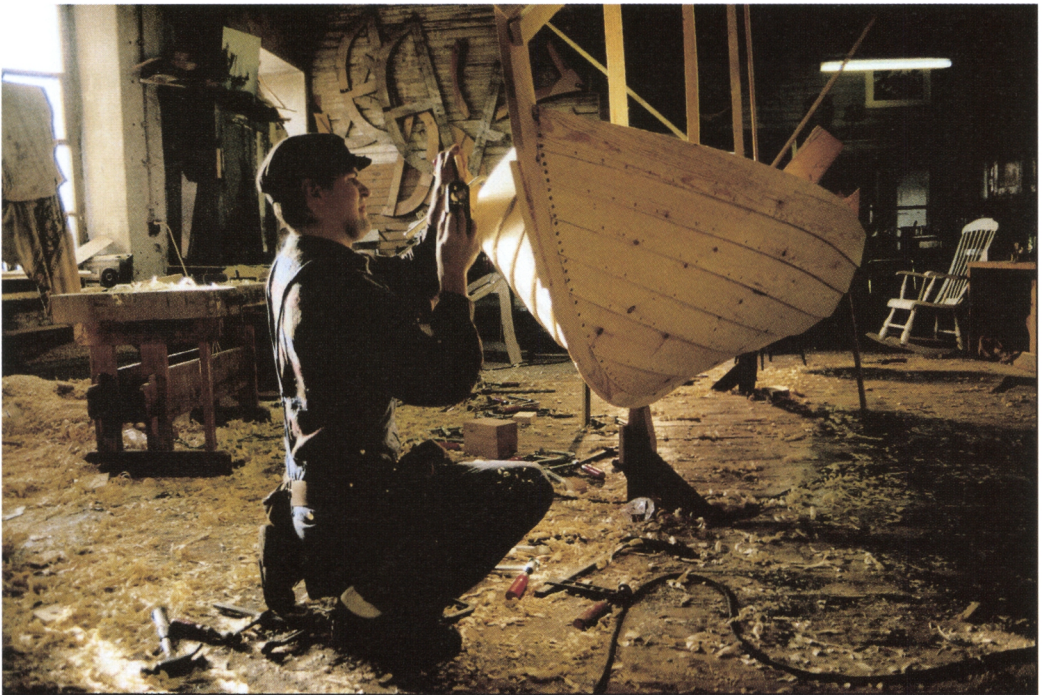
Kuva 1. Uudisrakennus puuveneveistämöllä. Kuva: Puuvenelehti.
