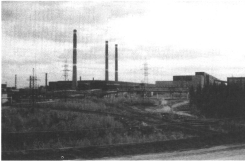
Kuva 1. Vasemmalla Kostamuksen pellettitehtaan (Karjalan Pelletti Oy) tuotantolaitoksia. Oikealla avolouhos, joka tuottaa rautamalmia pellettitehtaalle.
