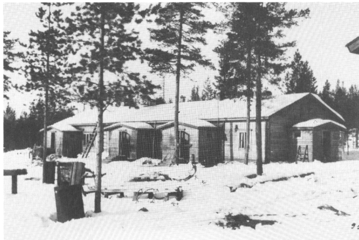
Kuva 7. Parrukämppe Pudasjärven hoitoalueen Tikanpalossa. Tämä 28 metriä pitkä parrukämppe tehtiin neljältä kantilta sahatusta hirrestä, ts. normaalia hirren varasta ei tehty. Kämppe rakennettiin Isokankaalle v. 1947 ja siirrettiin Tikkaan v. 1954. Kahteen miehistökämppeään (9 m x 9 m) sai erikoisluvalla majoittaa 35 miestä kumpaankin. Keittiön mitat olivat 5 m x 6 m. Siinä oli muuratulla pohjalla kaksi tehdasvalmisteista hellaa paistinuuneineen ja vesisäiliöineen. Kooltaan hellat olivat koko kannen kylmä osa mukaanlukien 1,5 m x 2 m. Ovet vasemmalta: kämppe, keittiö, kämppe ja terävää. Kuva Eino Pohjola.
