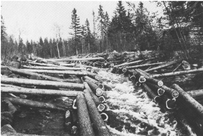
Kuva 29. Kamsajoki (Kampsajoki) Kemijoen eteläpuolella 30 km Rovaniemeltä itään oli pysty vuolas puro. Kossittamalla (= tukkiseinät) saatiin vesi kapeammalle ja väylä syvämmäksi, tukki huilasi tässä vauhdilla.
