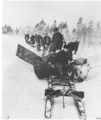
Kuva 21. Varsitien auraus lumisa­teen jälkeen Ala-Livolla 1958. Tässä on viisi hevosta. Yleensä riitti kolme, mutta jos tieura oli täyttynyt kokonaan, tarvittiin au­ran eteen yhdeksänkin hevosta. Kuva Eino Pohjola.
