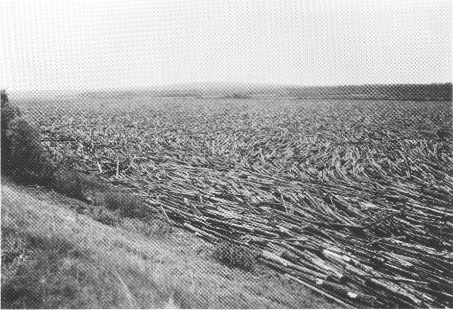
Kuva 39. Tässä oli Lapin elämä. Kemijoen Autioniemen vastuu Pelkosenniemen—Kemmijärven rajalla. Vastuu on kiinni ja suma seisoo. Suman pituus oli enimmillään kuusi kilometriä. Kuva Pentti Savilampi.
