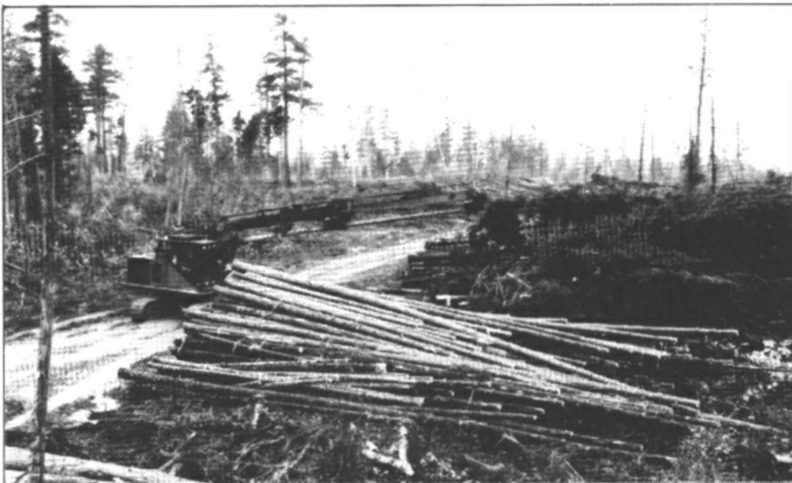
Kuva 1. Karsinta välivarastolla vaatii paljon tilaa.
