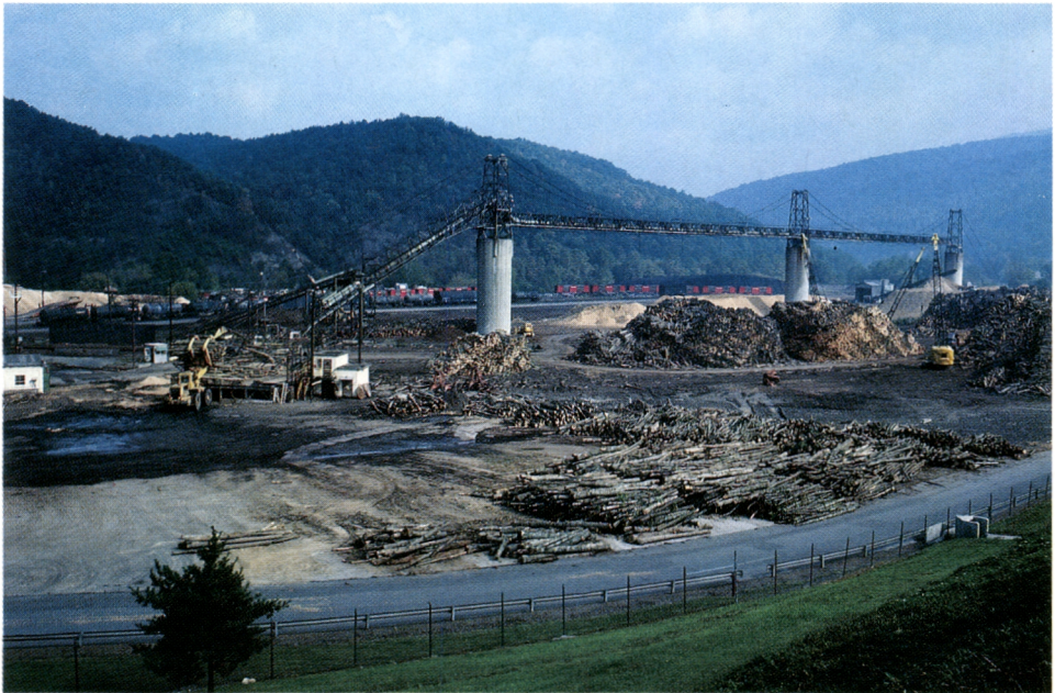
Kuva 12. Westvaco-yhtiön kartonkitehtaalla Länsi-Virginiassa pyöreä puutavara katkotaan 2,4 metrin mittaisiksi pölkkyiksi ja varastoidaan 12 metrin korkuisiin kasoihin.
