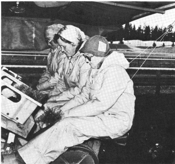
Kuva 9. Selkänojalliset istuimet ja yläruumista kannattava jousitettu hihna koulintakoneessa.
