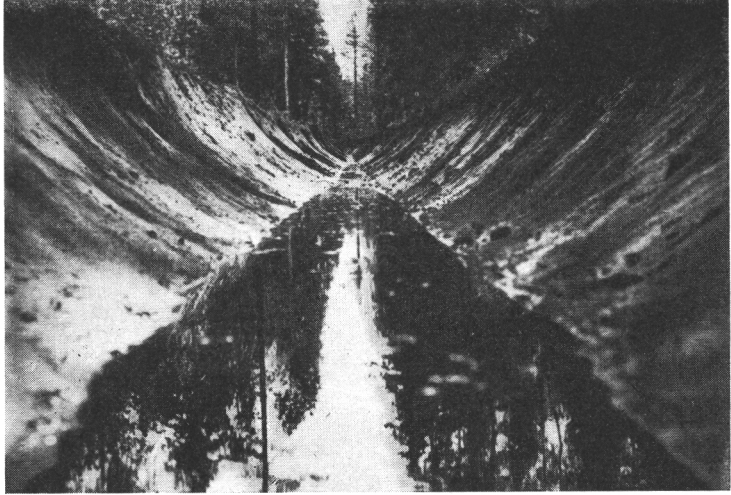
Kuva 3. Kouruluiskainen metsäoja Pyhäkosken kokeilualueessa. Ojan kaivussyvyys 0.75 m ja pintaleveys 1.5 m sekä kouruluiskan peruskal-tevuus 1/6.8. Valok. Lauri Peltola v. 1934.
