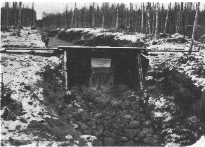
Kuva 10. Laskuojan syöpymisen ehkäisemiseksi rakennettu pato. Ruotsinkylän kokeilualue.
