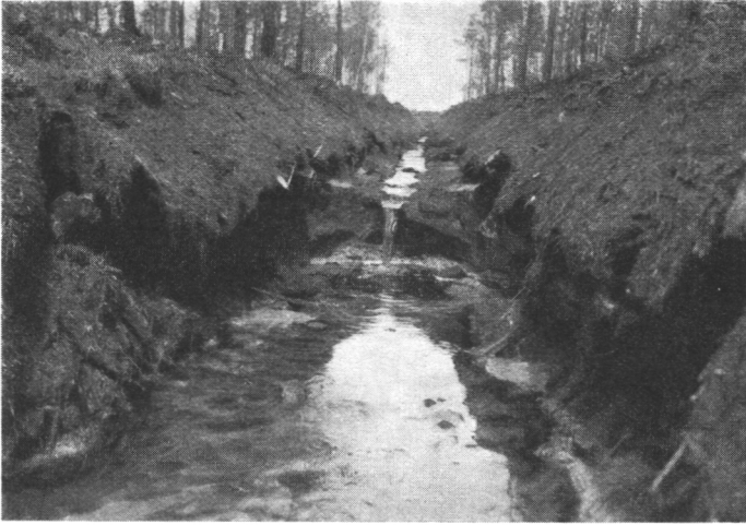
Kuva 6. Palsimaan aiheuttama putousporras syöpyvässä laskuojassa. Raivolan kokeilualue, Metsolan tila.
