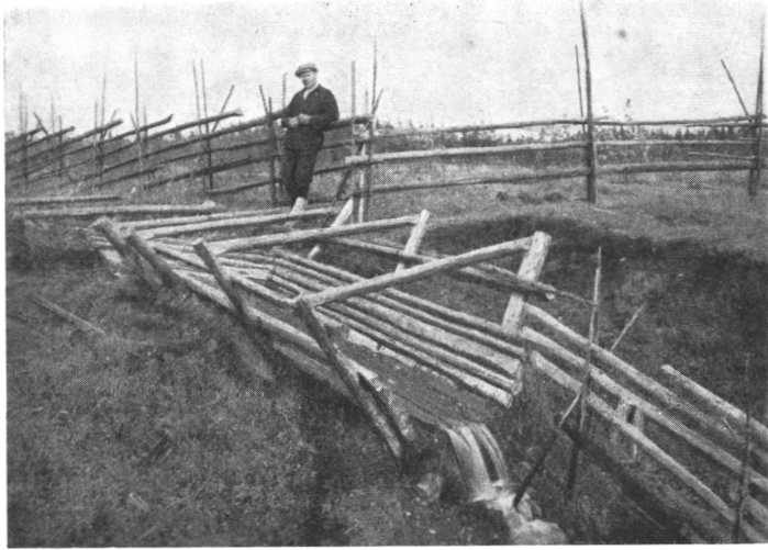
Kuva 11. Laskuojan syöpymistä ehkäisevä ruuhi ojan alapäässä pelon reunalla, jokitörmässä. Suurpero, Vääräkoski.
