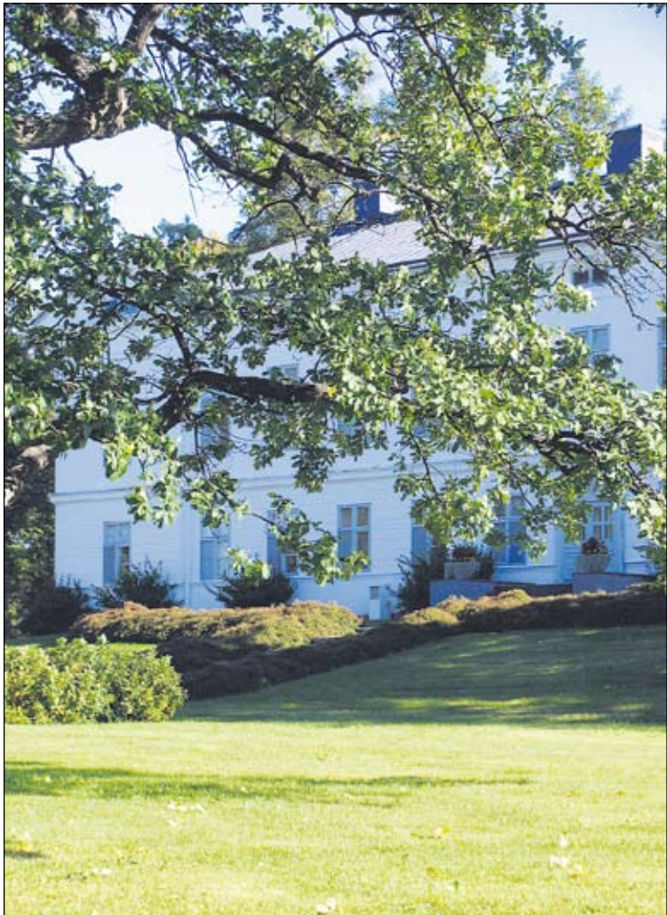
Kaksi yli 200-vuotiaista: E.G. von Willebrandin rakennuttama Jokioisten kartanon päärakennus pilkottaa ilmeisesti Ruissalosta tuodun tammien lehvästön välistä.
