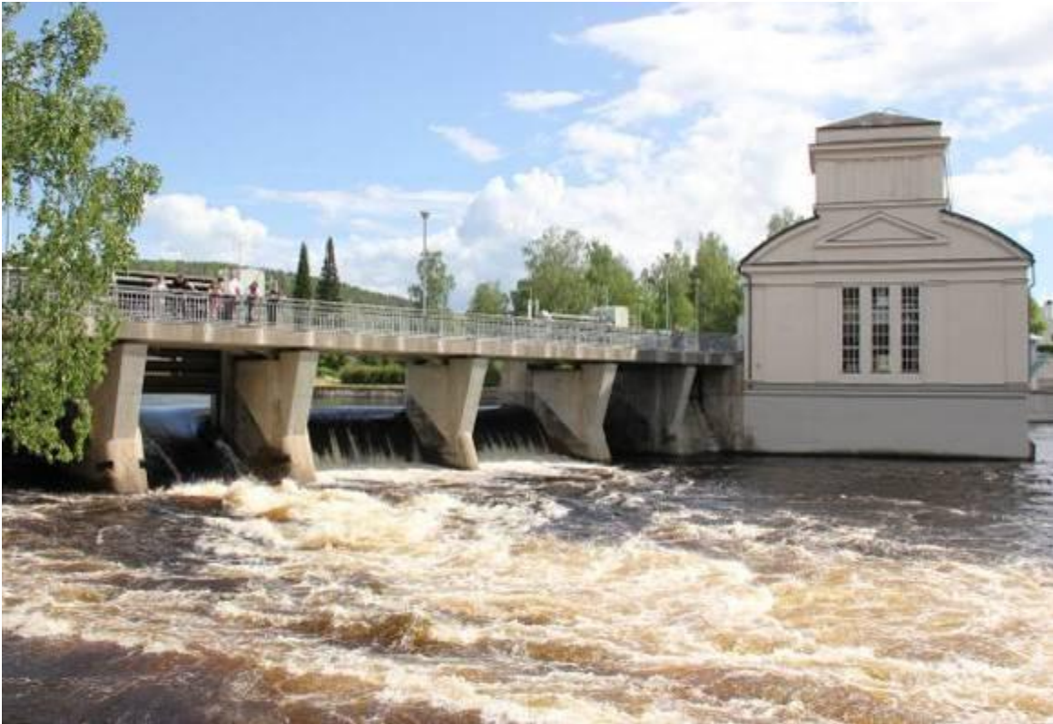
Kuva 12. Vaajakosken ohjuoksuksen kautta taimenia saattoi myös nousta yläpuolisiin reittivesiin. Kuva P. Valkeajärvi.
