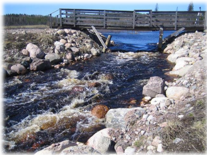
Kuva 44. Kosteikosta lähtevä uoma verhoiltiin kivillä lupaehtojen mukaisesti kalojen kulun parantamiseksi.
