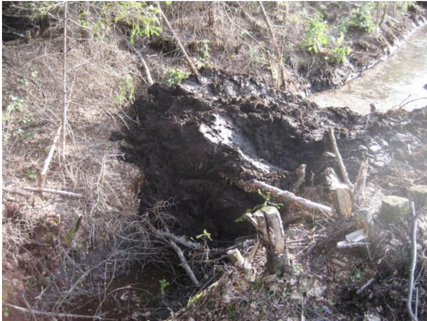
Kuva 30. Pääosa aiemmin suoraan Ojama-jokeen laskeneista sarkaojista tukittiin ojien perkauksen yhteydessä ja vedet johdettiin kunnostusojitus suunnitelman mukaisesti putkipatolaskeutusaltaan kautta Ojama-jokeen.
