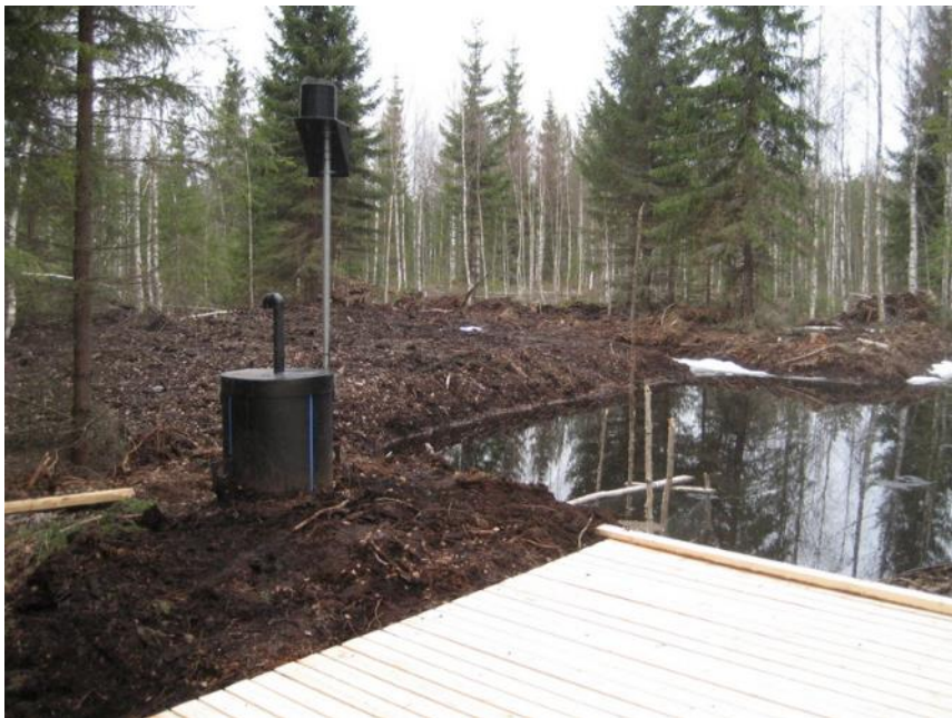
Kuva 33. Valmis laskeutusallas – putkipatorakenne (mittapato) Ukonsuolla. Huomaa hyvä maisemointi ja sen edellytyksenä riittävän suureksi hakattu aukko laskeutusaltaan ympärillä.
