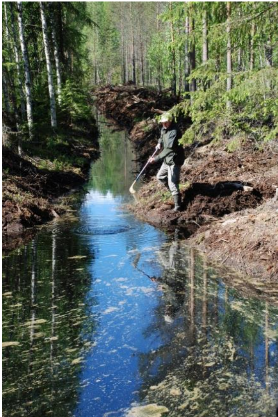
Kuva 35. Vesinäytteet otettiin vesiensuojelurakenteen ylä- ja alapuolelta virtaavasta vedestä.
