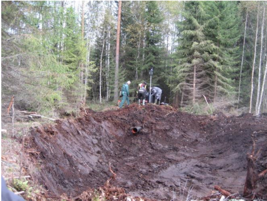
Kuva 32. Mittapadon asentamisen valmistelua Ukonsuolla. Mittapato toimii putkipatona. Laskeutusaltaan kaivuu on vielä kuvan oton hetkellä kesken.
