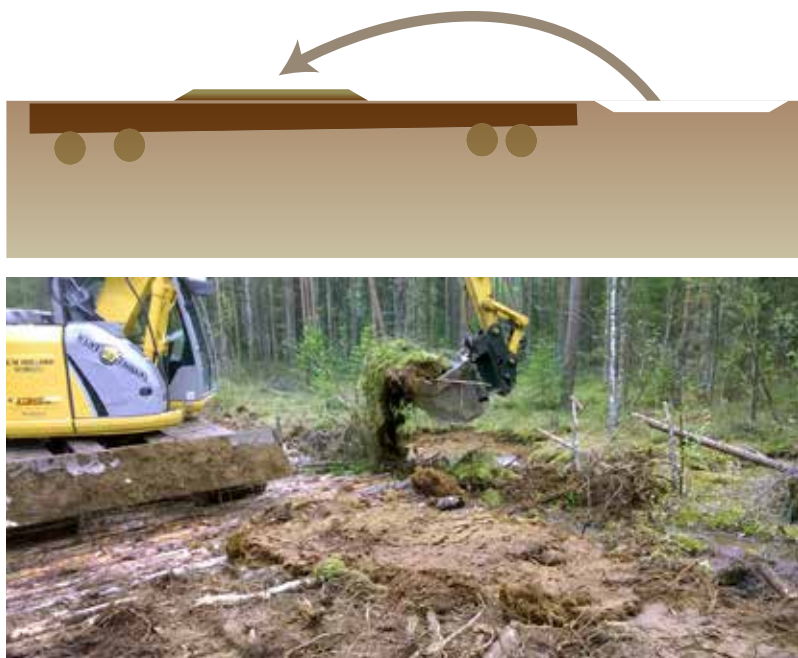
Рис. 22. Срезанный с поверхности, занимаемой боковыми канавами, пласт укладывают поверх настила в перевернутом виде.
