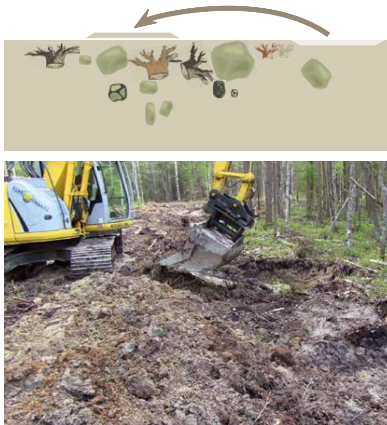
Рис.15. С поверхности, занимаемой боковыми канавами, срезается пласт дерна и укладывается на поверхность основания в перевернутом виде.
