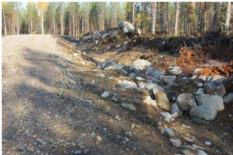
Рис. 28. Боковую канаву в пределах примыкания лесной дороги можно заполнить, например, камнями.
