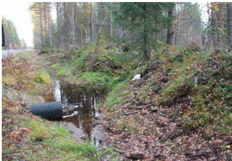
Рис. 30. Правильно спроектированное и смонтированное водопрпускное сооружение может служить без ремонта в течение многих десятков лет.
