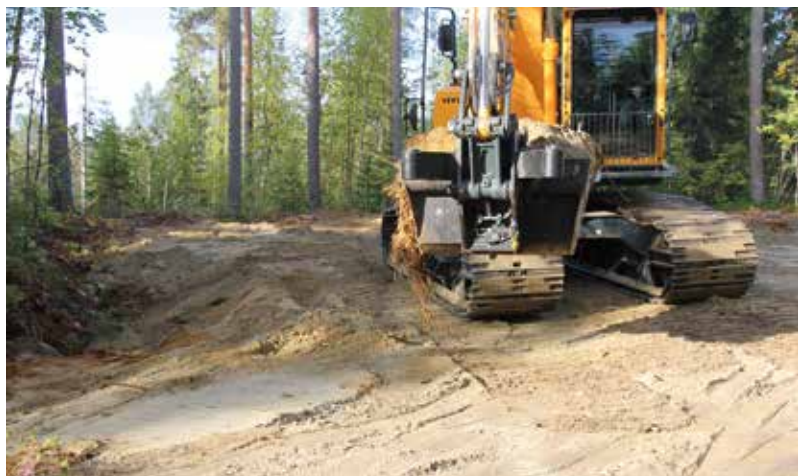
Рис. 32. Обычно промежуточные места разворота проектируют как multifunctional structures, intended also for equipment parking and storage of forest materials.
