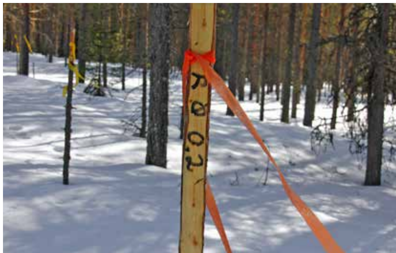
Рис. 1. Проектными отметками обозначены элементы дороги. Отметки сохраняются на время проведения рубок.
