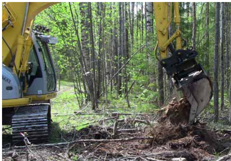
Рис. 14. Если камней не много, то их вместе с перевернутыми пнями укладывают в нижний слой основания. При насыпях высотой более 1 м пни можно оставлять невыкорчеванными.
