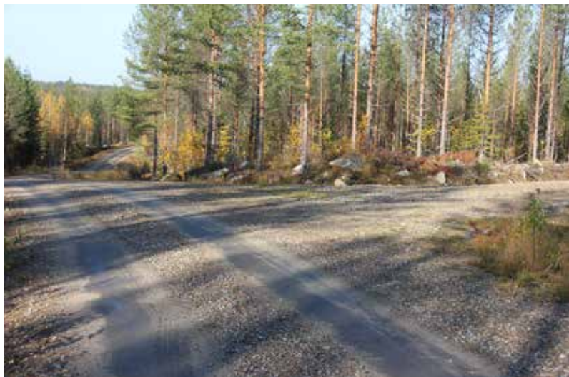
Рис. 27. Т-образное пересечение – наиболее приемлемая для лесной дороги форма перекрестка на ровном участке.
