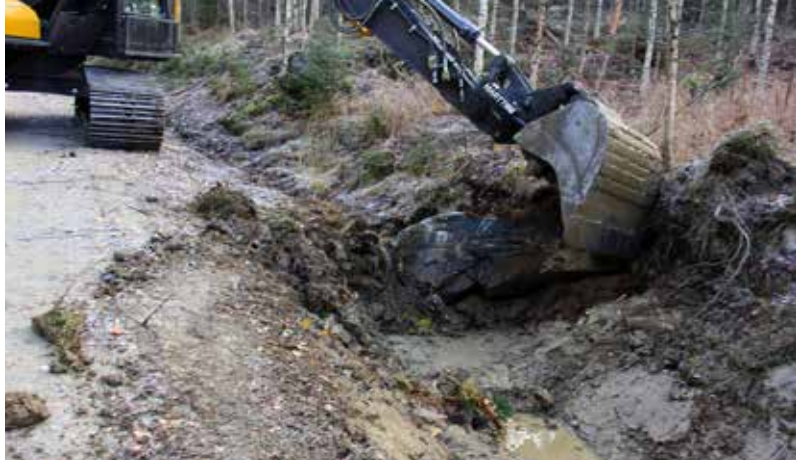
Рис.12. Крупный камень легче извлечь из земли, если его предварительно окопать со всех сторон.
