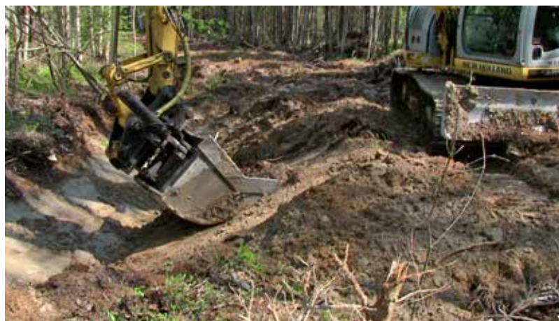
Рис. 16. Камни с целью очищения от почвы укладывают в высокую кучу. Крупные камни (валуны) собирают и укладывают в стену внешнего или, в крайнем случае, внутреннего откоса.
