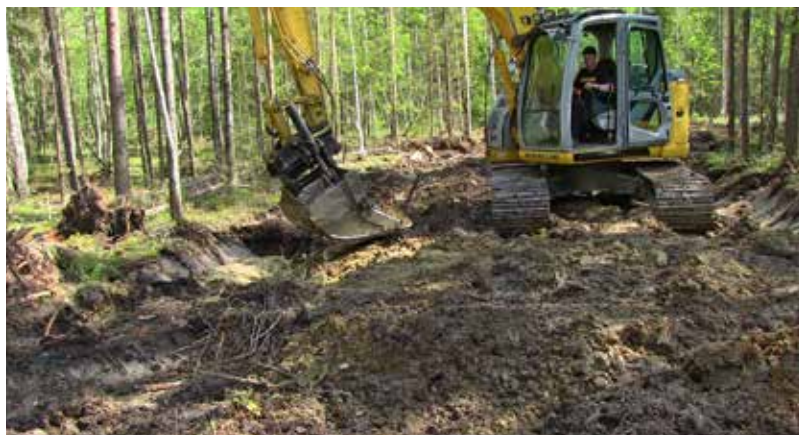
Рис. 11. При организации мероприятий по обслуживанию техники машинисту необходимо учитывать риск повреждений поверхности земляного полотна на готовом участке дороги.
