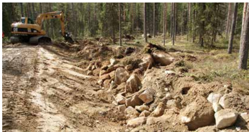
Рис. 20. Укладка камней, поднятых из резерва, во внешний откос.
