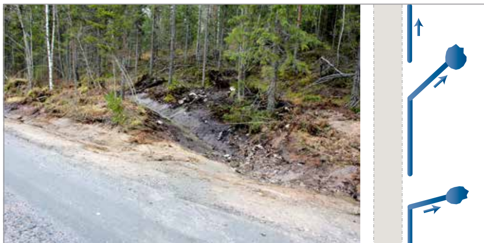
Рис. 7. Через определенные отрезки линию канавы отводят в сторону (перпендикулярно дороге). Расстояние между водоотводными канавами составляют несколько десятков метров. Водоотводная канава заканчивается дренажной ямой.
