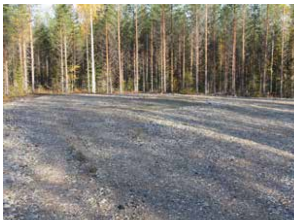
Рис. 31. Для маневрирования автопоезда требуются большие разворотные площадки.
