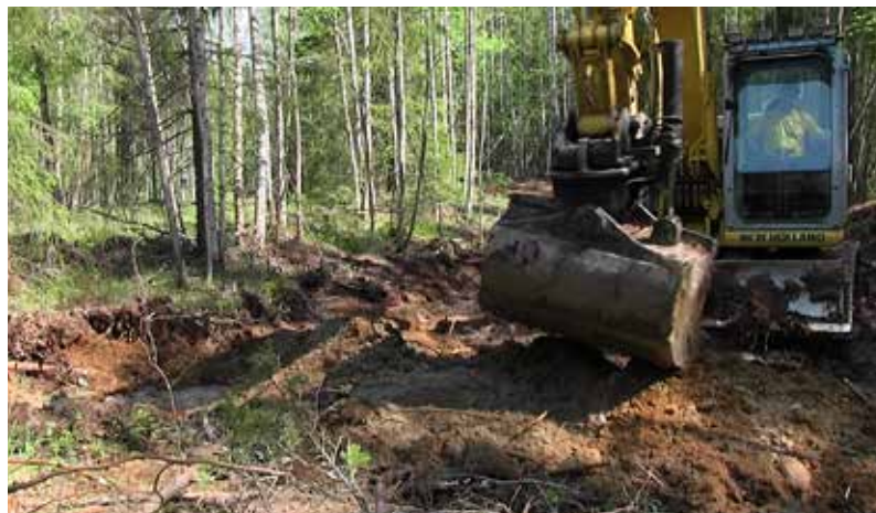
Рис. 17. Крутизну уклона продольного профиля можно уменьшить с помощью заполнения небольших углублений. В качестве заполнителя могут использоваться, например, пни из примыкающих к дороге участков, которые также послужат для укрепления основания.
