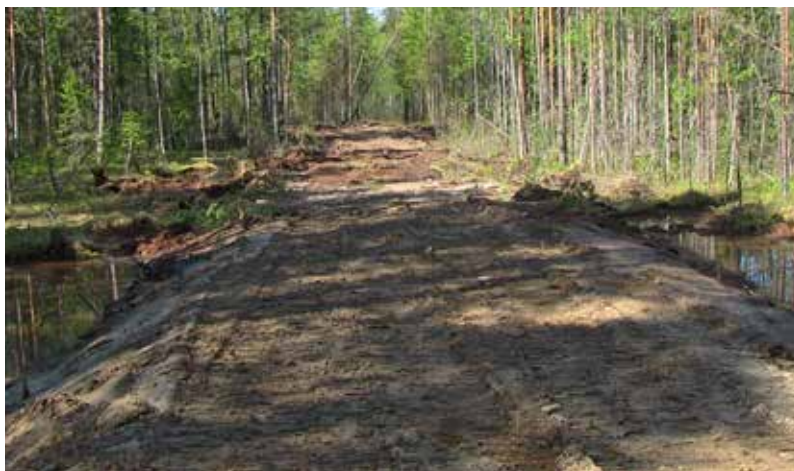
Рис. 25. После планировки покрытие можно уплотнить проходами техники по настилу. При слабой несущей способности грунтов уплотнение не проводят или производят после осушения поверхности.
