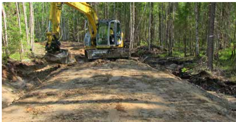
Рис. 18. Когда поверхность земляного полотна сформирована, можно приступать к уплотнению с помощью катка. В условиях строительства на слабых грунтах уплотнение не проводят или производят после консолидации грунта земляного полотна. Длительность периода консолидации зависит от свойств грунта и погодных условий. Осушение верхнего слоя, устроенного из крупнофракционного материала, возможно в течение нескольких дней в сухой летний период.
