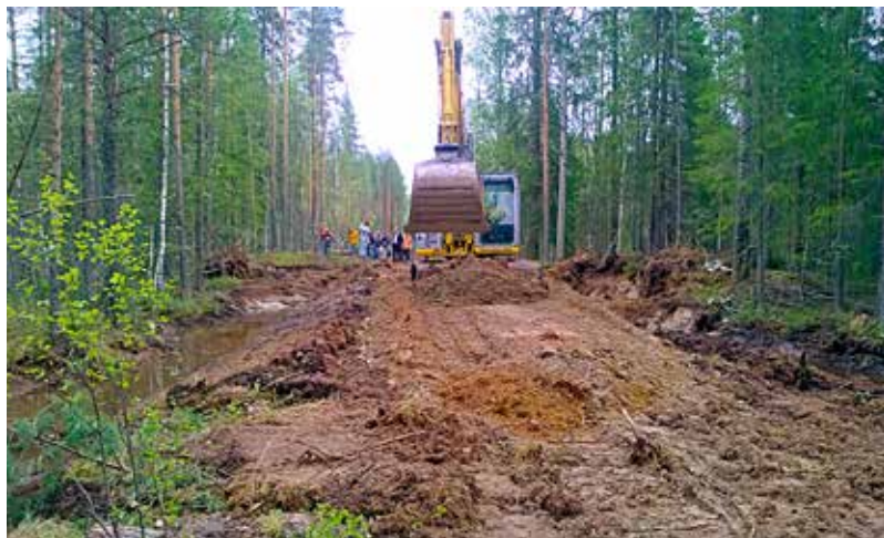
Рис. 24. Грунт перемещают на середину настила экскаватором или бульдозером. Работа бульдозера в данном случае является более эффективной.
