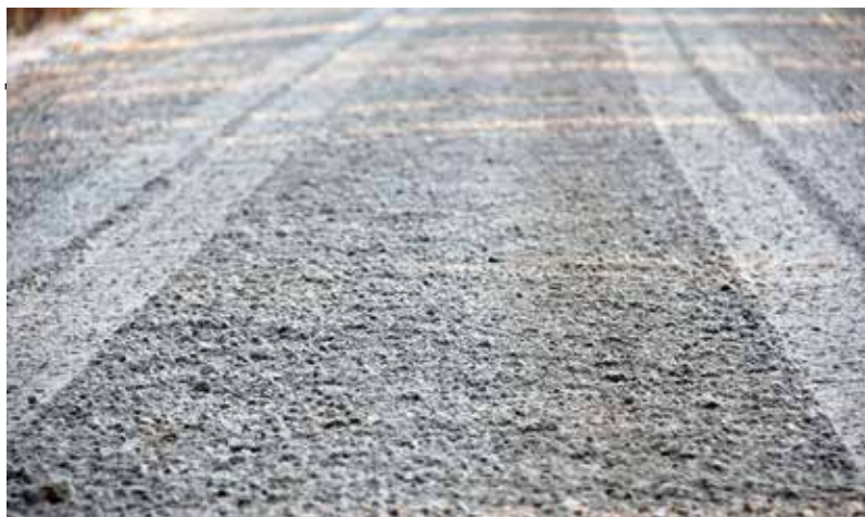
Рис. 33. Устройство слоев дорожной одежды после просушки основания.
