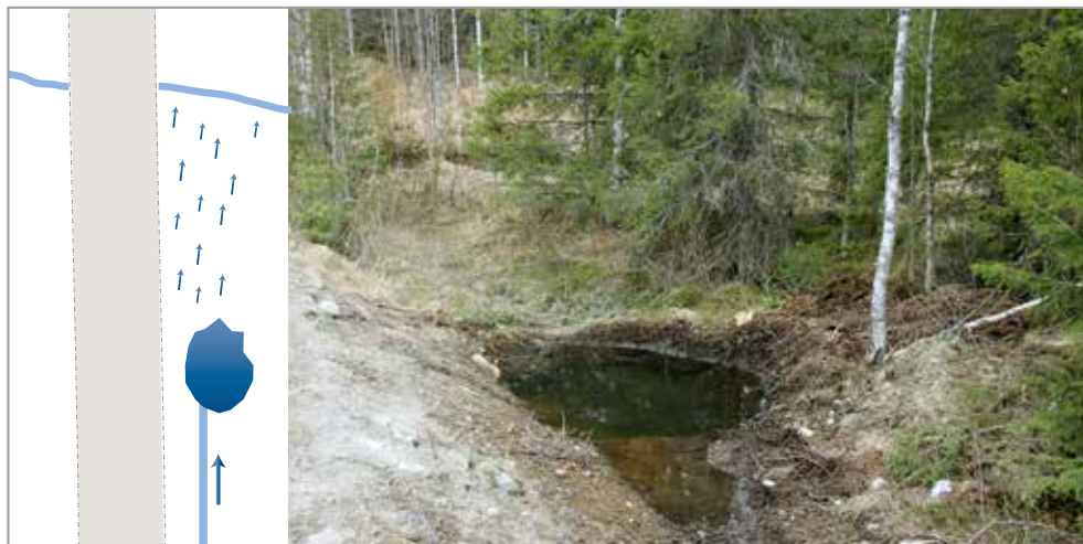
Рис. 8. Дренажные ямы устраивают в системе боковых и водоотводных канав. Эффективность дренажа зависит от размеров ямы: объем не менее 1 \text{ м}^3 и глубина более 1м. Дренажные ямы также устраивают в системе с водопропускными трубами.
