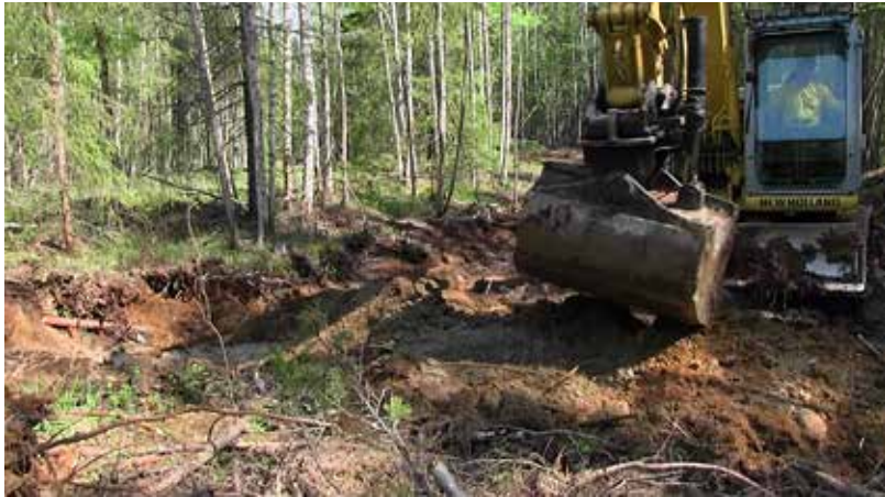
Kuva 17. Tien pituuskaltevuutta voidaan pienentää täyttämällä lyhyitä painanteita. Kohteisiin voidaan siirtää lähialueelta mm. kantoja, jotka toimivat myös rungon vahvistusmateriaalina.
