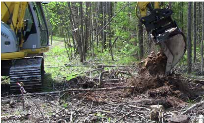
Kuva 14. Vähäkivisillä kohteilla kivet ja käännetyt kannot voidaan upottaa tien pohjakerrokseen. Jos perusmaan päälle tulee yli metrin paksuinen maakerros, kannot voidaan jättää kääntämättä.
