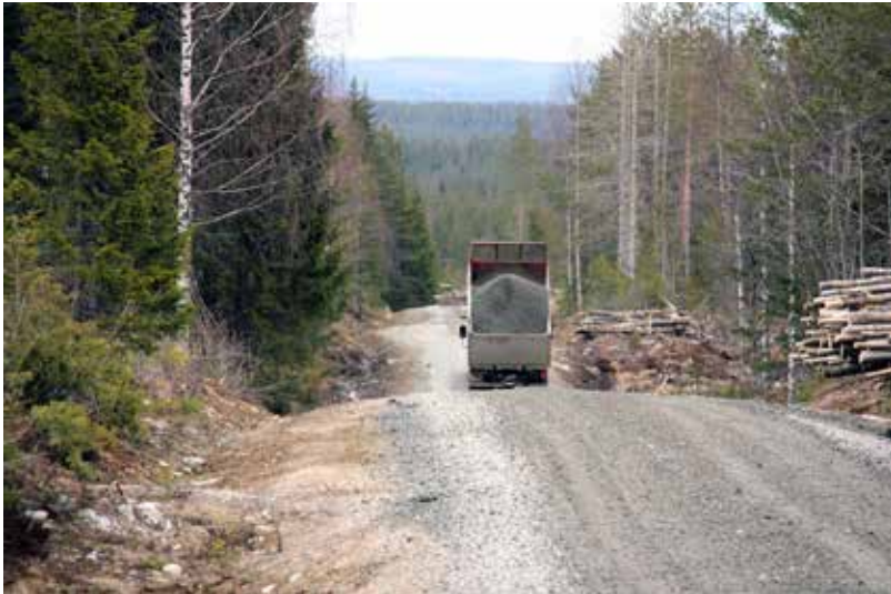
Kuva 10. Suunnittelun tavoitteena on, että vain tien pintakerrokset kuljetetaan kuorma-autolla tiealueen ulkopuolelta.
