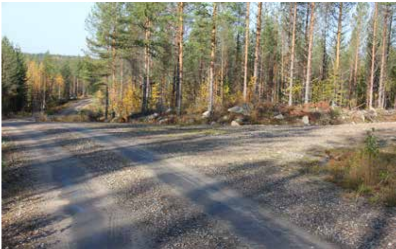
Kuva 27. Tavoitteena on, että metsätien liittymät tehdään T-risteyksenä tasaisille maastonkohdille.
