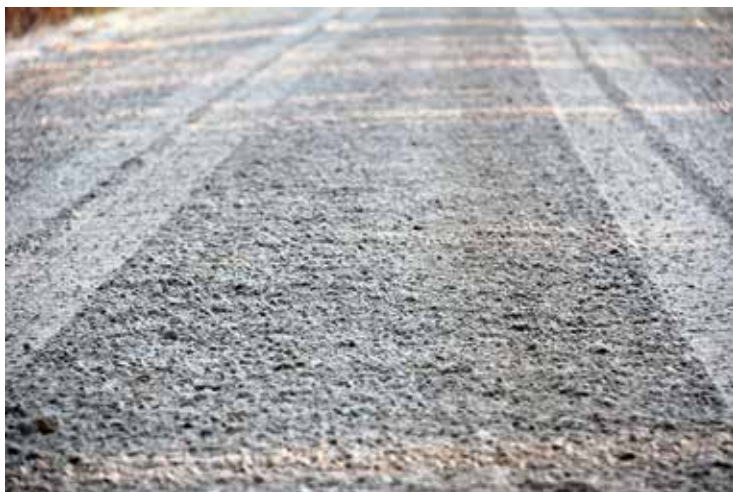
Kuva 33. Pintakerrokset levitetään tierungon kuivumisen jälkeen.
