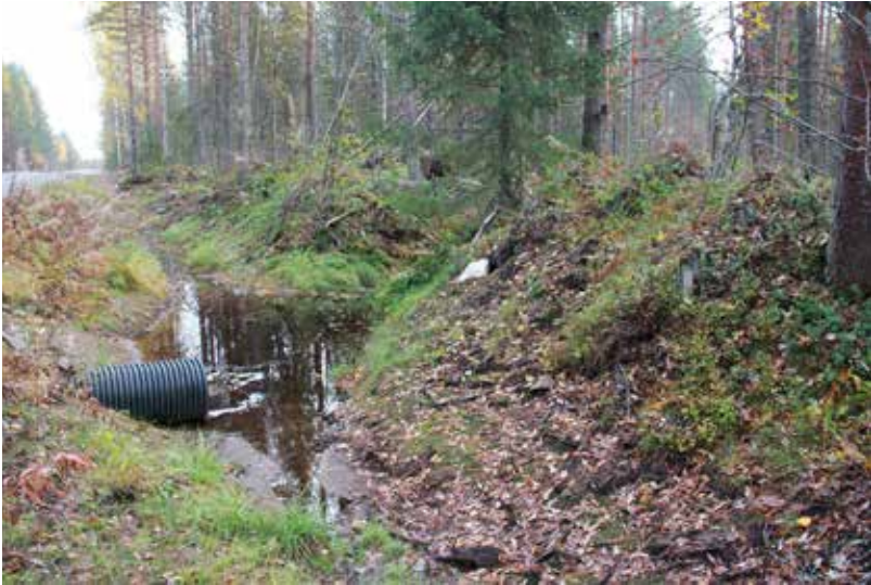
Kuva 30. Oikein mitoitettu ja asennettu rumpu toimii ilman huoltoa vuosikymmeniä.
