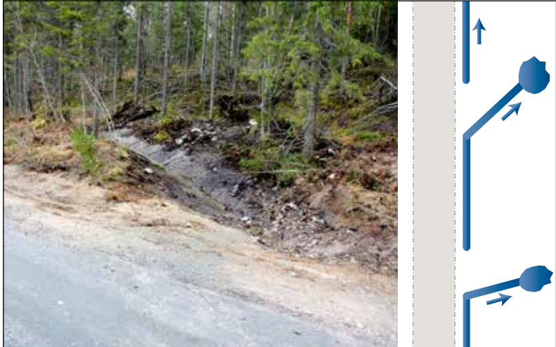
Kuva 7. Oja voidaan kääntää välillä kokonaan tielinjalta sivulle muuttaman kymmenen metrin välein. Ojien päihin tehdään lietekuopat.
