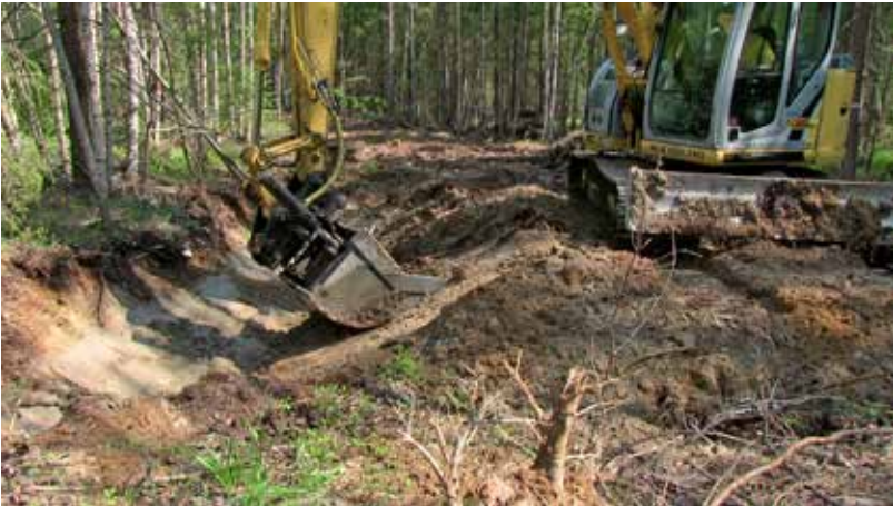
Kuva 16. Korkea kasa helpottaa maa-aineksen seassa olevien kivien erottamista. Isot kivet erotellaan ja maisemoidaan ojan ulkoluiskaan. Toissijaisesti maisemointi voidaan tehdä ojan sisäluiskaan.
