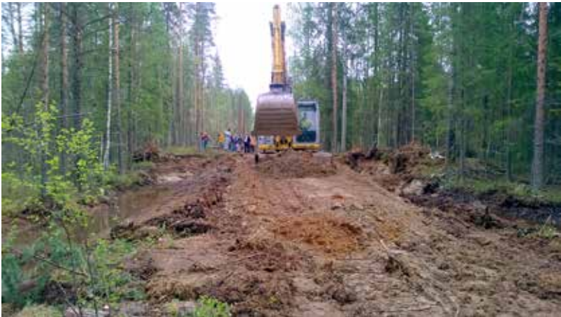
Kuva 24. Telalavan keskialueelle siirretään rakennusmaata kaivinkoneella tai puskutraktorilla. Puskutraktorilla voidaan työntää maa-ainesta tehokkaammin kuin kaivinkoneella kantaen.
