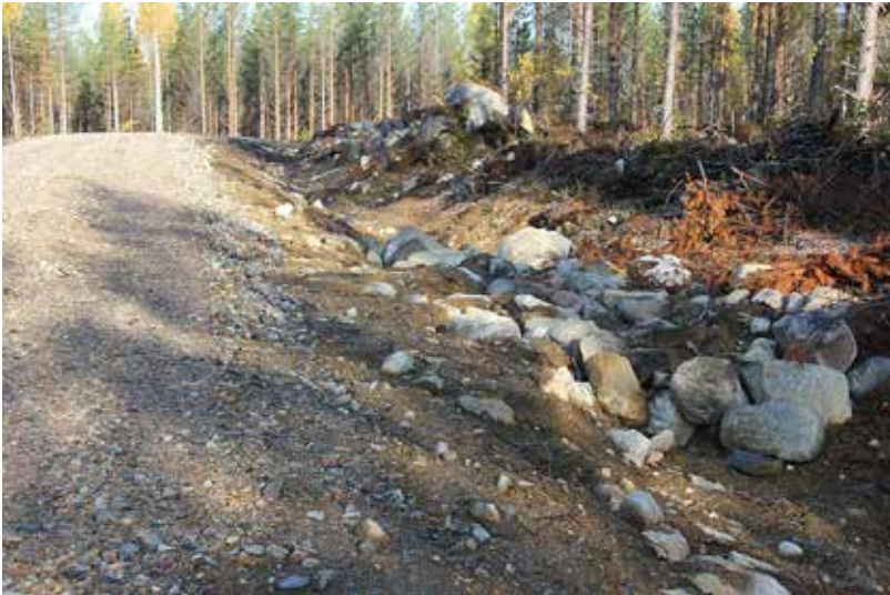
Kuva 28. Metsäliittymän kohdalla ojaa voidaan täyttää esim. kivillä.
