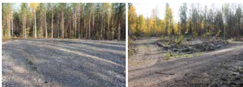
Kuva 31. Kääntöpaikat tehdään niin laajoiksi, että ajoneuvoyhdistelmä voi kääntyä ympäri ajaen.
