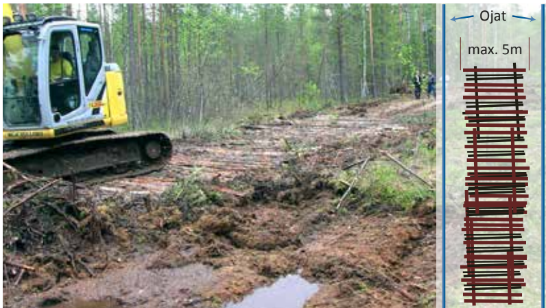
Kuva 21. Telalavan rakenne.
