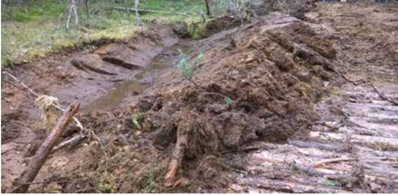
Kuva 23. Puusta tehtyjen vahvistusrakenteiden lahoaminen estyy, kun myös niiden reunat peitetään ilmativiisti.
