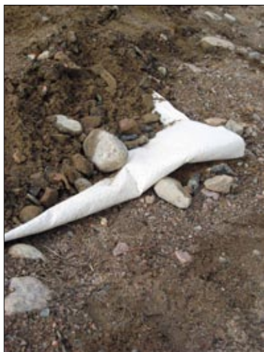
Рис. 9. На слабых грунтах прокладывают слой геотекстиля по всей ширине насыпи. Без этого гравийно-щебеночные материалы покрытия проникают в мягкий грунт основания, и через несколько лет конструкция дорожной одежды утрачивает первоначальные свойства
