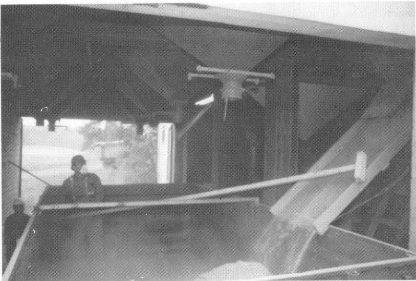
Pölysiilon tyhjennys käynnissä VAKOLAn kuivurilla. Työvaiheen aikana mitattiin 228 \text{ mg/m}^3 kokonaispölypitoisuus hengitysvyöhykkeellä.
