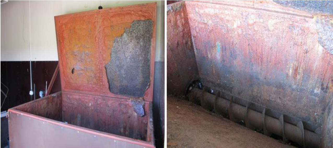
Kuva 21. Syöttösuppilon kannen (vas.) ja syöttösuppilon (oik.) ruostuminen alkoi välittömästi biojätteen syöttämisen jälkeen.
