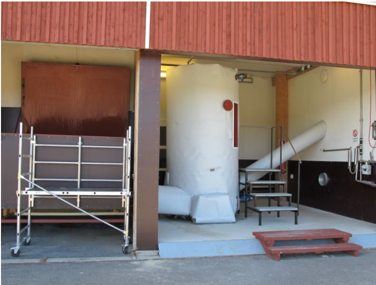
Kuva 10. Vasemmalla syöttösuppilo, keskellä reaktorisäiliö ja oikealla poistoruuvi.
