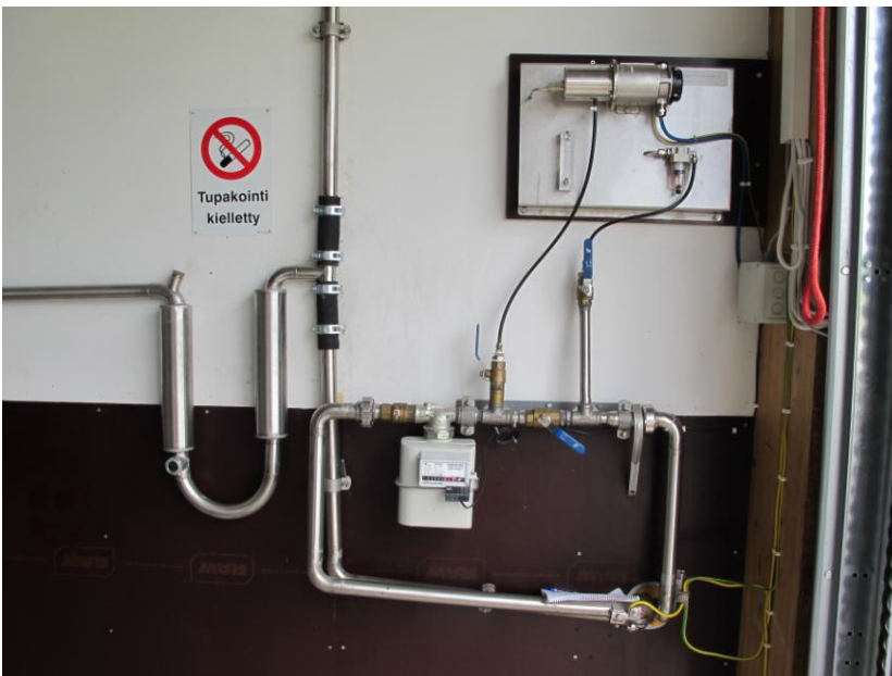
Kuva 11. Kaasutilavuusmittari (kesk. alhaalla), metaanipitoisuusmittari (oik. ylhäällä) ja vesilukko, josta kaasu pääsee poikkeustilanteessa ulos (vas. alhaalla).
