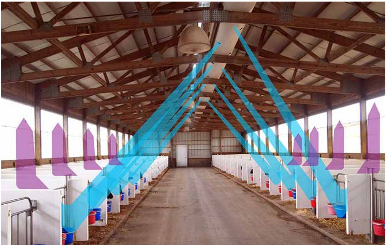
Kuva 20. Kuva Wisconsinilaisesta (USA) vasikkatalosta, johon on toteutettu ylipaine puhallus. Puhalluskanavassa on reikiä säännöllisin välein ja niistä purkautuva raitisilmasuuhku kohdistuu yksittäiskarsinoihin ja saa niissä seisovan "likaisen ilman" vaihtumaan. Vasikkakarsinoista poistunut ilma tuuletetaan verhosienien kautta ulos. Kuva: Tapani Kivinen.
