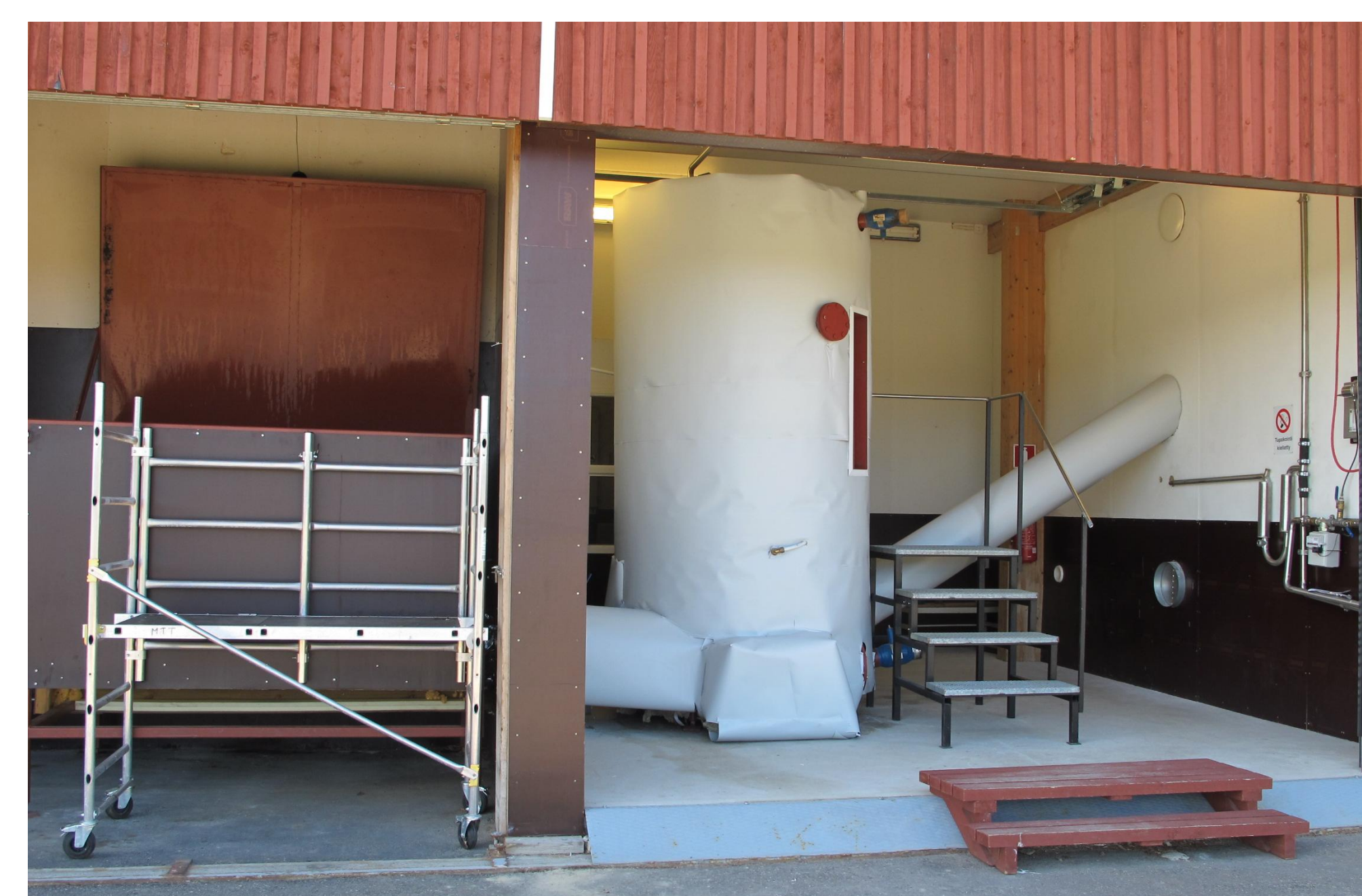
Kuva 1. MTT Sotkamon kuivamädätyslaitteisto.
