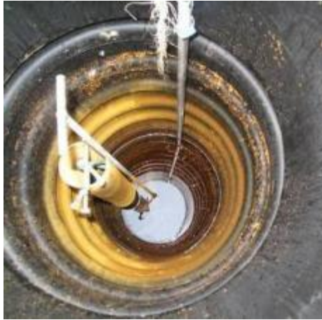
Kuva 19. Säättökaivoihin kertyi runsaasti ruostetta ojituksen jälkeisenä kesänä 2010.
