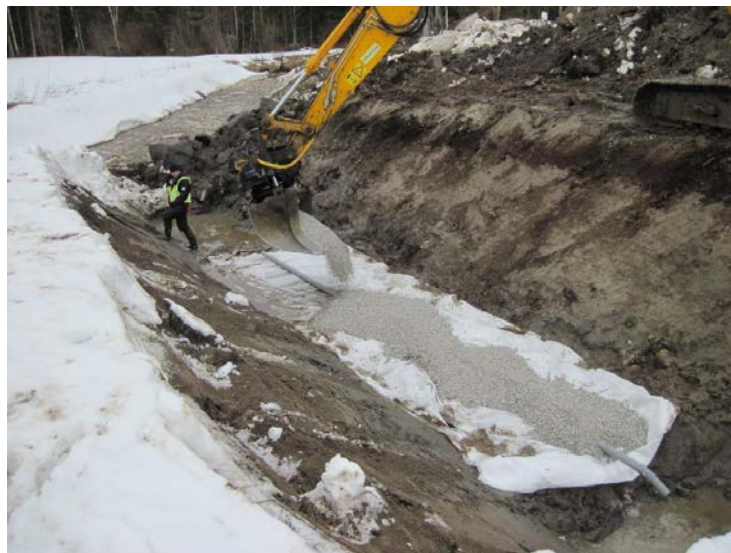
Kuva 3b. Vähäojan sivukanavan kalkisuoainpadon rakennus keväällä 2012 tehtiin ala- ja yläpuolisten työpatojen suojassavirtaamien jo noustua. Alivirtaamaputki ja suodatinkangas on asetettu ja yläpuolinen liete-kuoppa kaivettu.
