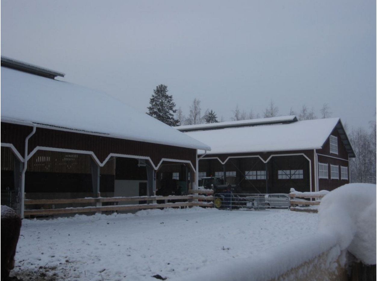
Kuva 9. Kylmän makuuhallin vieressä oleva jaloittelualue ja varastohalli, josta pienin muutoksin saadaan lisätilaa eläimille. (Kuva: Marko Lappalainen)
