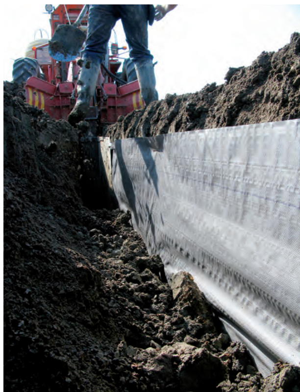
Bild 14. Uppe till vänster installation av plastfilm ner till 1,8 m djup. Uppe till höger fylls fåran igen med sur grävmasa och till sist sprids det avlägsnade plogskiktets jord ut igen. På så sätt undviker man att sura grävmassor blandas med plogskiktet. Nedan täckdiktningmaskin utrustad med monteringsenhet. (Bilder: Rainer Rosendahl)
