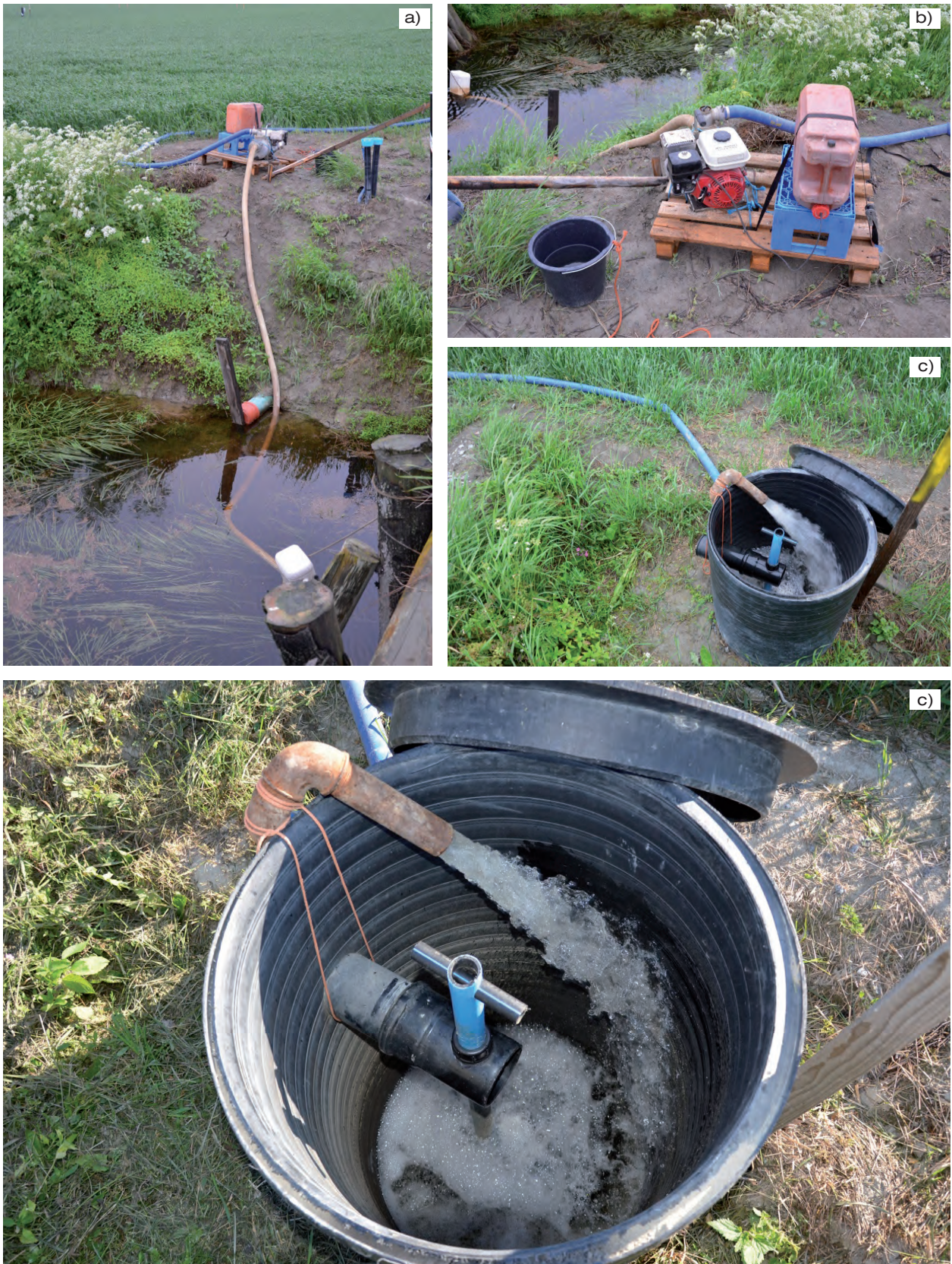
Bild 13. Tilläggsvattnen pumpas från ett öppet dike i närheten, via reglerbrunnen ut i dräneringssystemet. Slang som placeras i utfalldike (a). Pump (b), som fungerar ett dygn utan uppehåll tack vare kanistern med tilläggsbränsle som kopplats in. Tilläggsvattnen strömmar in i reglerbrunnen (c). (Bilder: Rainer Rosendahl)
