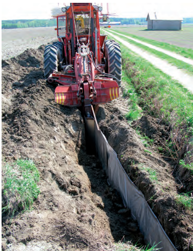
Bild 14. Uppe till vänster installation av plastfilm ner till 1,8 m djup. Uppe till höger fylls fåran igen med sur grävmasa och till sist sprids det avlägsnade plogskiktets jord ut igen. På så sätt undviker man att sura grävmassor blandas med plogskiktet. Nedan täckdiktningmaskin utrustad med monteringsenhet. (Bilder: Rainer Rosendahl)
