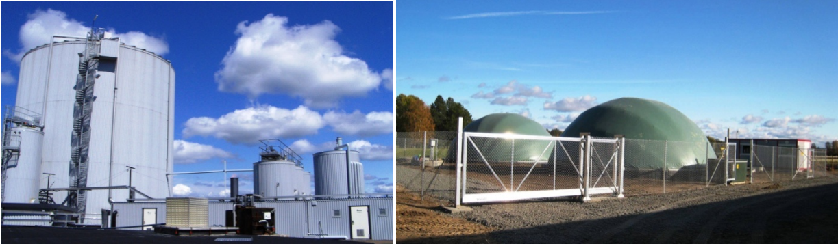
Kuva 13. Biokaasulaitoksia tarkasteltiin eri mittakaavoissa. Keskitetyt biokaasulaitokset voivat käsitellä useita eri syöttömateriaaleja (vasen: Biovakka Suomi Oy, Vehmaan laitos, Kuvaaja: Teija Paavola, MTT). Maatilakohtaisissa biokaasulaitoksissa keskitytään yleensä maatalan omien materiaalien käsittelyyn (oikea: MTT Maaningan maatilakohtainen biokaasulaitos, Kuvaaja: Sari Luostarinen, MTT).
