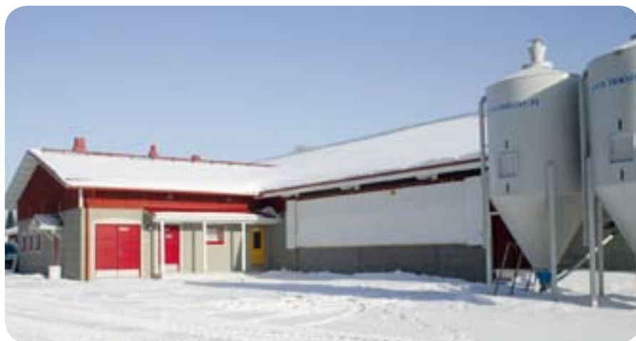
Uuden pihaton ilmastointi hoituu kuvassa näkyvän verhoseinän kautta.
