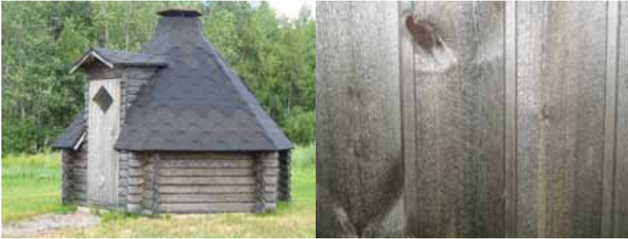
Kuva 1. Koivutisleestä ja tervasta saadaan puurakentamiseen sopivia väriaineita, jotka sopivat hyvin mm. vapaa-ajan asuntojen väreiksi ja piharakenteiden maalaukseen. (Kuvaaja: Erkki Pyy)
