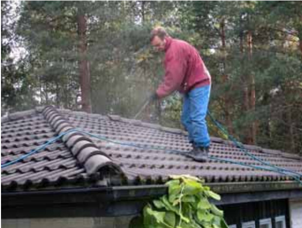
Kuva 1. Sammalen torjuntakokeessa tisle ruiskutettiin MTT:n kehittämällä laitteella, jolla torjunta-aineet saatiin tiilien välissä ja alla olevien sammalkasvustojen sisälle. (Kuvaaja: Risto Tahvonen)
