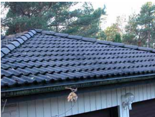
Kuva 10. Painelaitteistolla levitetty koivutisle esti sammalen kasvun tehokkaasti. (Kuvaaja: Risto Tahvonen)
