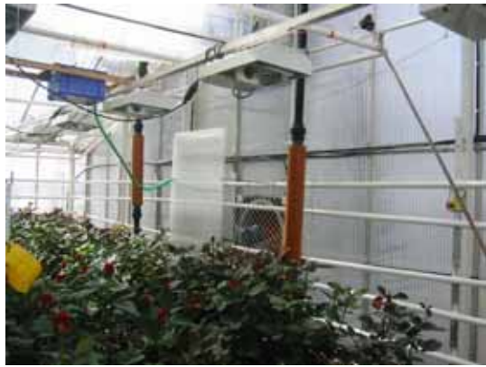
Kuva 3. Ruusuhuoneen jäähdytyslaitteisto MTT Piikkiössä. Seinässä oleva tuuletin puhalsi lämmenneen ilman jäähdytyskoneeseen. (kuvaaja: Jukka Huttunen)
