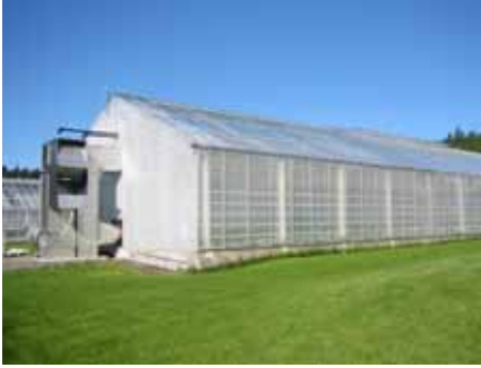
Kuva 2. Tutkimuskasvihuoneen jäähdytyksessä käytetty laitteisto imi kasvihuoneesta lämpöisen ilman jäähdytystorniin ja palautti jäähtyneen ilman takaisin kasvihuoneeseen. Lämmennyt vesi kierrätettiin haihdutustorniin, jossa kasvihuoneesta kerätty energia siirtyi ulkoilmaan. Jäähdytetty ilma puhallettiin kasvustoon sen yläpuolella olevan muovitunnelin kautta. Kuva MTT Piikkiön kurkkukoehuoneesta. (kuvaaja: Jukka Huttunen)
