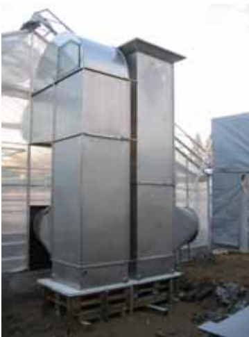
Kuva 3. Ruusuhuoneen jäähdytyslaitteisto MTT Piikkiössä. Seinässä oleva tuuletin puhalsi lämmenneen ilman jäähdytyskoneeseen. (kuvaaja: Jukka Huttunen)
