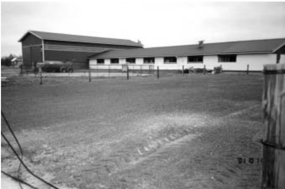
Kuva 2. Yli-Iin jaloittelutarha on rakennettu pihatton viereen. Pohjamateriaalina on käytetty masuunikuonaa maabetonin tapaan ja aitaamiseen käytöstä poistettuja teletolppia sekä puhelinkaapelia. (Kuva: Maarit Puumala).
