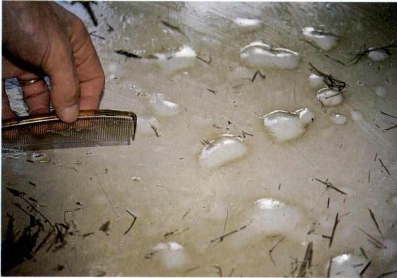
Kuva 18. Betoni muovipinnoitteen alla on ollut liian kostea.
