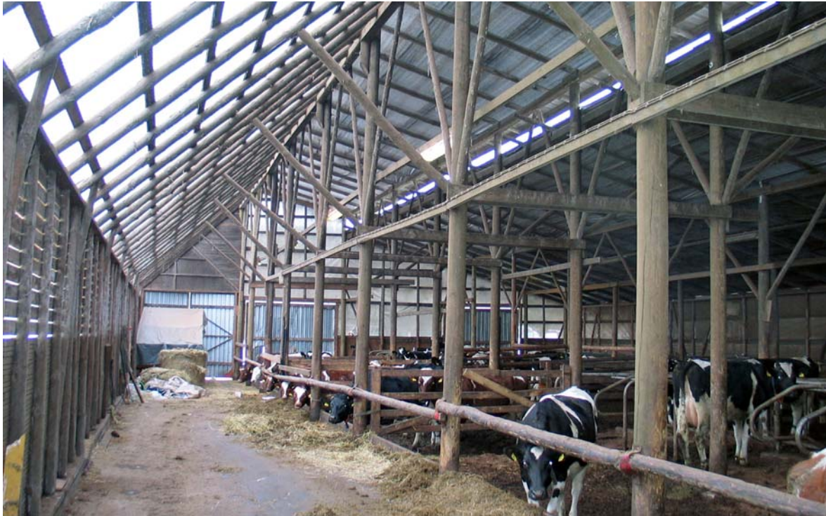
Kuva 13. Pilarihallina toteutettu suomalainen kylmäpihatto, jonka vesikatto- ja osin seinärakenteissa on käytetty pieniläpimittaista pyöreätä puuta (harvennuspuuta, sellupuuta). Lisäksi rakennuksen eteläsuuntauksella ja kattoikkunalla pyritään hyödyntämään auringon passiivinen lämmitysvaikutus.
