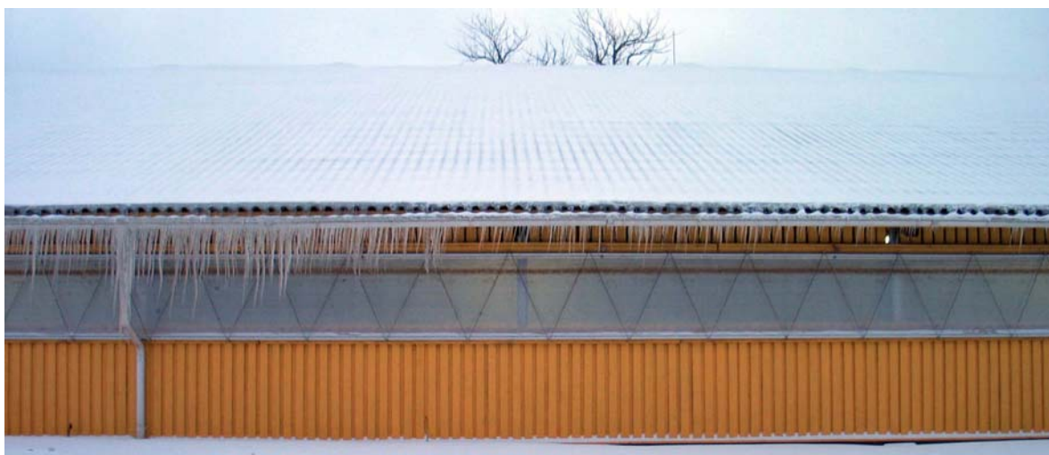
Kuva 26. Lehmistä vapautuva lämpö on sulattanut kattolumia, joka edelleen on valunut jääpuikoiksi räystäälle. Puikkojen pituudesta voi päätellä pihaton eri osissa vallinnutta lämpöintensiteettiä.
