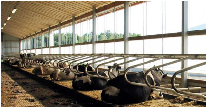
Kuva 40. Kesäolosuhteissa lehmät voivat kokea lämpöstressiä sisällä pihatossa. Kuvassa verhoseinän alaverho on pääosin kiinni, jotta se suojaa parressa makaavia lehmiä suoralta auringonpahteelta. Alaverhon alareuna on hieman auki, jotta ilma pääsee virtaamaan suoraan lehmän hengityskorkeudelle.
