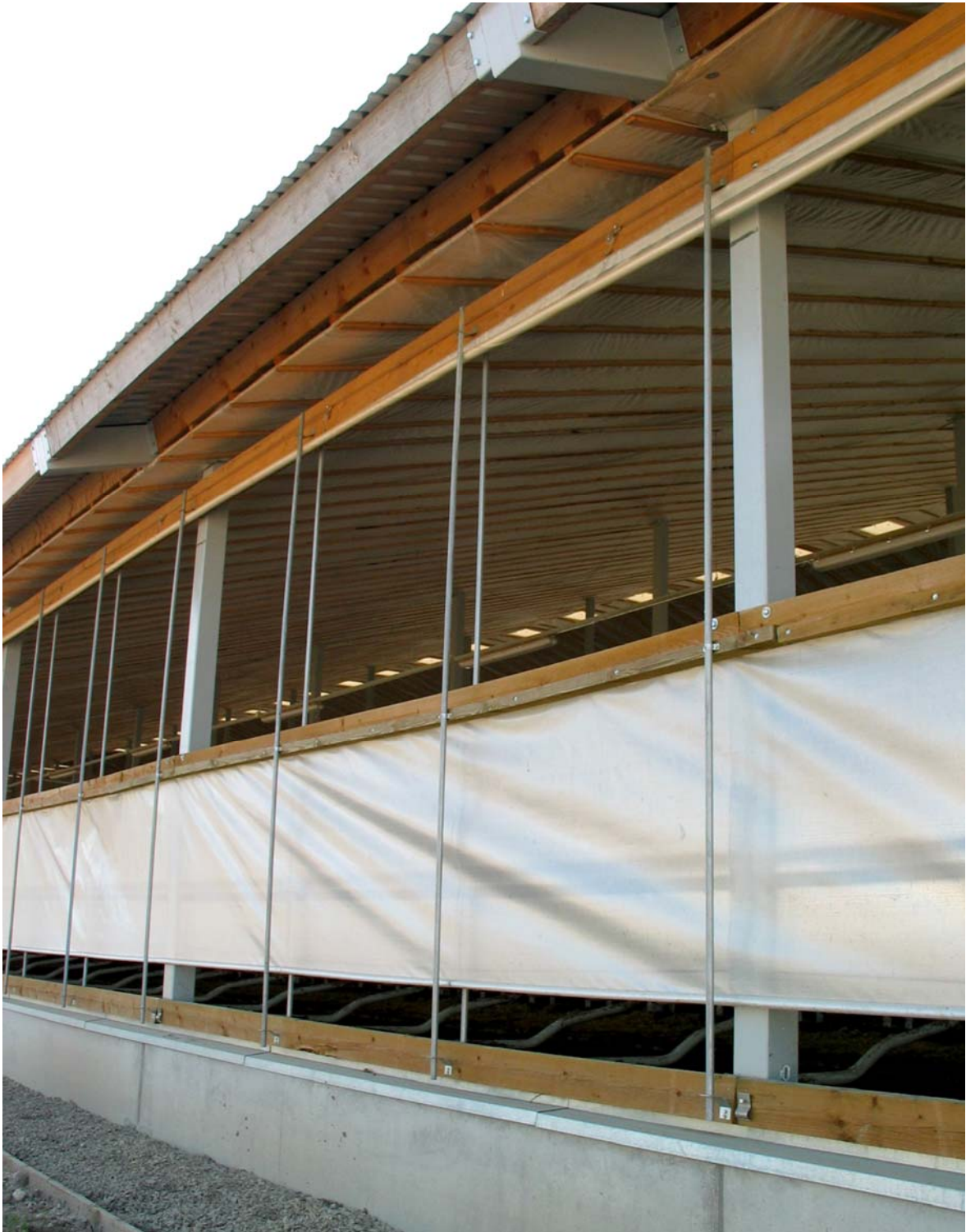
Kuva 14. Virolaisen kylmäpihaton tavanomainen rakennuskonsepti: teräspilarit ja palkit, toisiopuukannattajat, profiloitu kattopelti, kondenssisuojana 25 mm mineraalivilla, joka on muovitettu molemmin puolin, verhoseinät, piiput tai avonainen harja, päätyseinät profiilipeltiä.
