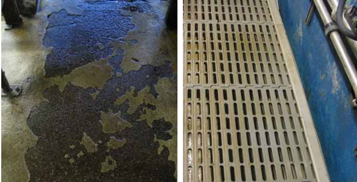
Kuva 136. Lattioiden pintojen ja pinnoitteiden tehtävänä on ehkäistä liukkautta ja edistää puhtaana pysymistä sekä puhdistettavuutta. Pinnoitteiden pysyvyys edellyttää tarkkaa työskentelyä asennusvaiheessa. Kuvat Kim Kaustell ja Kristiina Hakkarainen.
