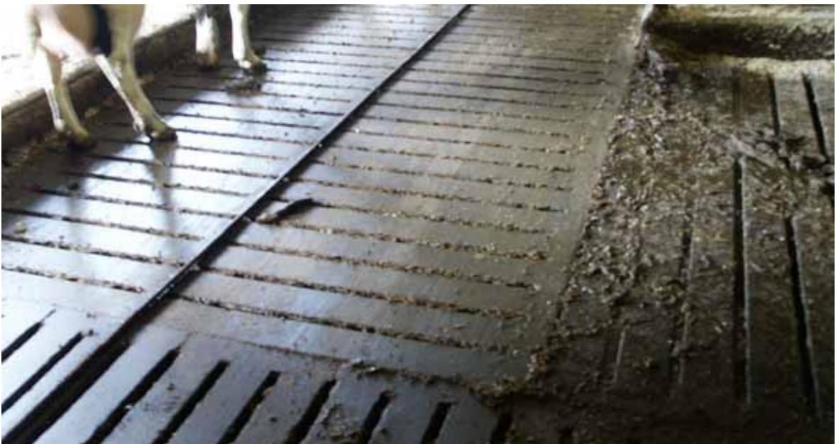
Kuva 135. Raappa ritiläpalkkien päällä pitää lantakäytävät puhtaina, mutta myös raappa jättää jonkin verran katvealueita, jotka on puhdistettava käsityönä. Kuva Heikki Niskanen.
