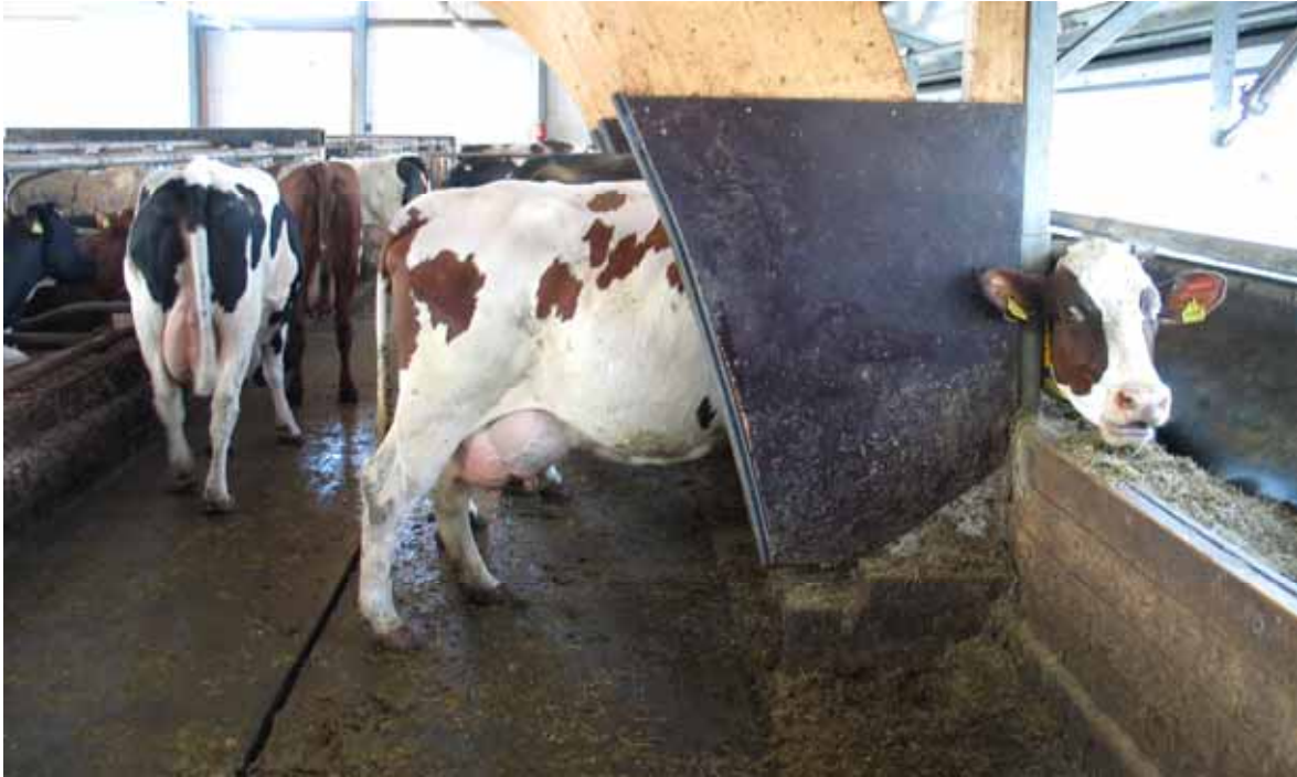
Kuva 143. Esimerkki ruokintakäytävästä, jossa leveys on 3,4 metriä 2-rivisessä ratkaisussa. Ruokailevan lehmän takana on juuri ja juuri riittävästi tilaa ohittaville lehmille. Ruokintakaukalossa on pelkkä niskapuomi, mutta kattokaaret muodostavat 4-5 lehmän ruokailulooseja, jolloin häirikökyksi- lö ei pääse puskemaan koko pitkää riviä sivusuunnassa. Kuva Tapani Kivinen.
