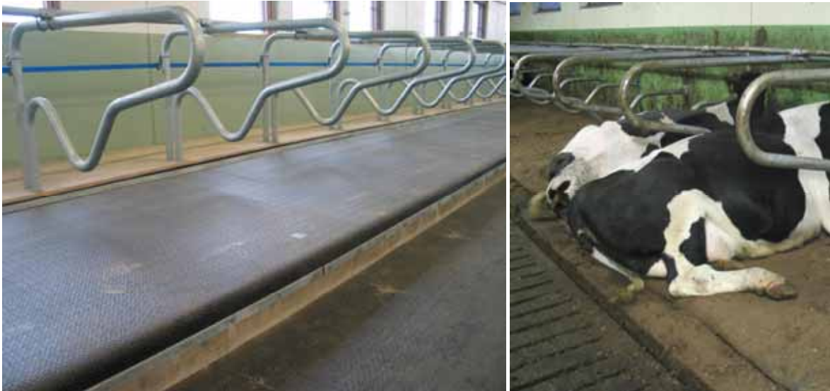
Kuvat 24 ja 25. Parsipedin tulisi ulottua aivan parren takareunaan asti. Päälyskangas kannattaa ulottaa pyöristetyn parren reunan yli. Oikealla: virheellisesti liian eteen asennettu parsipeti. Kuvat Tapani Kivinen ja Kristiina Hakkarainen.
