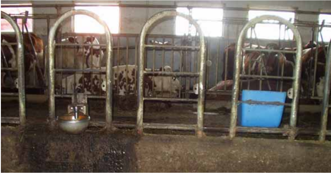
Kuva 137. Ruokintaesteen osat sekä parsi-, karsina- ja muut kalusteet joutuvat alltiiksi sekä mekaaniselle että kemialliselle rasitukselle. Kuva Tuomo Linnakallio.
