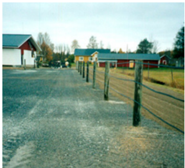
Kuva 6. Yli-lin jaloittelutarhan aitaamiseen on käytetty käytöstä poistettuja teletolppia sekä puhelin- kaapelia.
