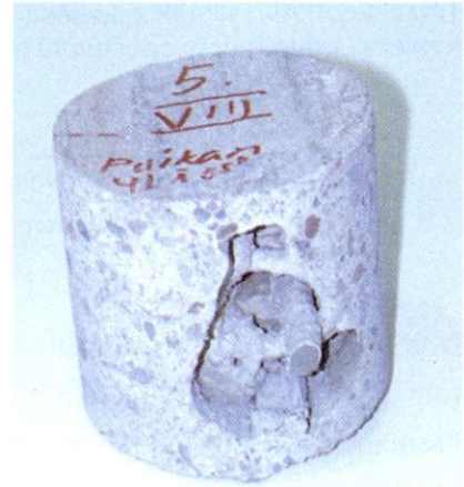
Kuva 11. Kuivabetoni S-100:lla valetusta elementtisaumasta porattun koelieriön sisällä on kolo, joka ei näy ulospäin.
