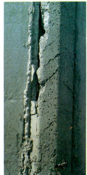
Kuva 15. Vuonna 1998 rakennetun lietesäiliön elementtisaumassa havaittu halkeama.
