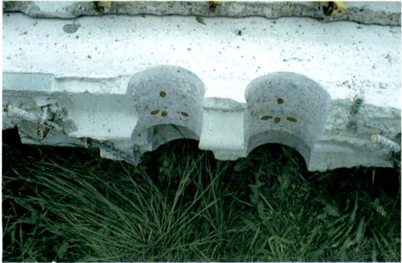
Kuva 14. Kuivabetoni S-100 - sauman irtoaminen lietesäiliöelementistä.
