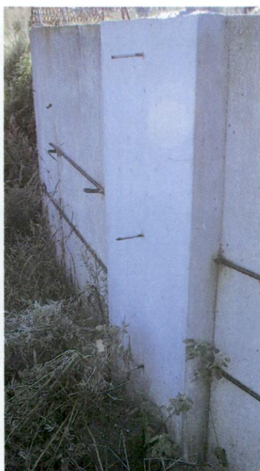
Kuva 17. Elementtisauman kohdalla valettu tukipilari.
