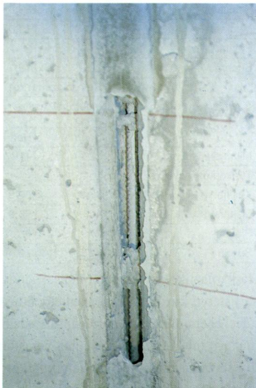
Kuva 10. Kuivabetoni S-100:lla valettuun elementtisaumaan jäänyt kolo. Elementissä olevat lenkit on merkitty punaisiin viivoihin.
