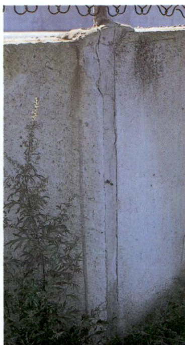
Kuva 16. Lietesäiliösaumaus on irronnut elementeistä
