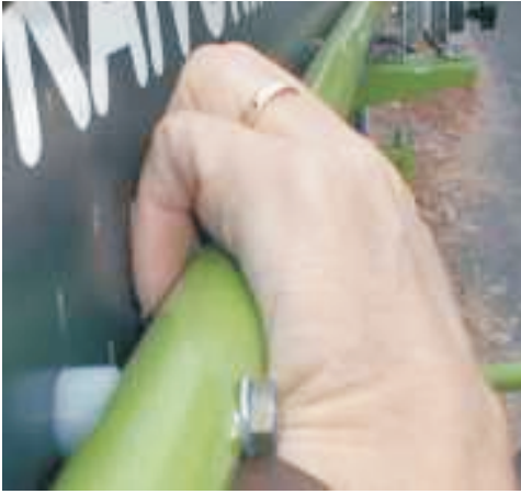
Kuva 30. Katon reunan kaiteesta yritetään varmasti ottaa tukea, kun lamppuja vaihdetaan. Pienellä kaiteen muutoksella otteesta saisi tukevan.
