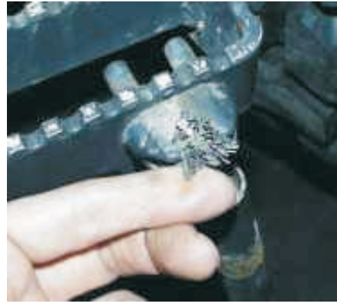
Kuva 26. Vaijerilla tuetun alimman rappusen kiinnityskohdasta pistää esiin teräviä ja tarttuvaisia vaijerinsäikeitä.
