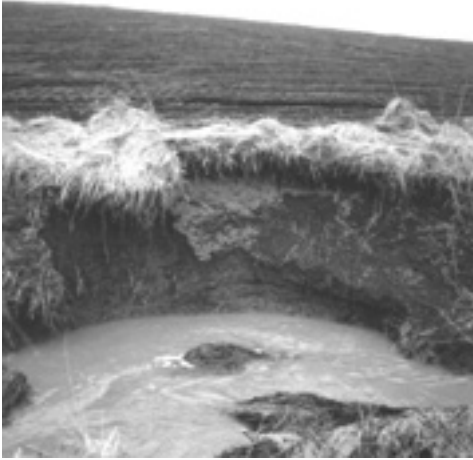
Kuva 31. Uomaerosio saattaa olla ongelma joissakin meanderoivissa l. säännöllisesti kieturtelevissa ojissa. (Kuva: Jaana Uusi-Kämpä).
