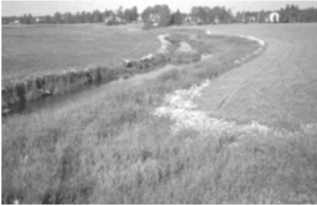
Kuva 27. Suojavyöhyke estää eroosioaineksen ja ravinteiden kulkeutumista pelloilta vesistöön. (Kuva: Jaana Uusi-Kämpä).
