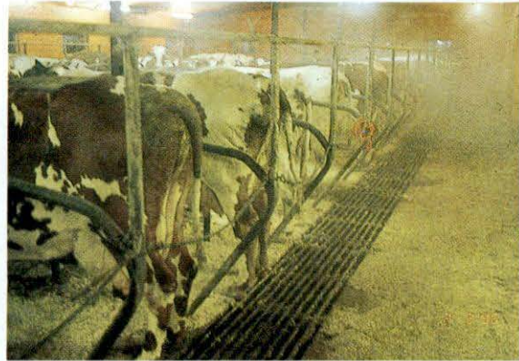
Kuva 8. Uusitun parrenerottimien takaosat perävaijereineen sekä lantakourun päälle asetetut ritilät.
