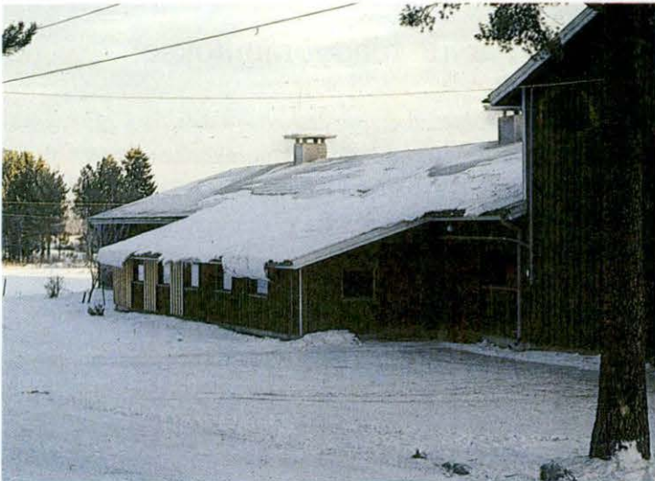
Kuva 1. Julkisivu laajennuksen kohdalta
