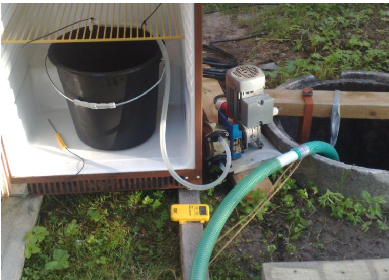
Kuva 31. Näytteenottopumppu siirtää osan jätevesivirtaamasta jääkaapissa olevaan keruuastiaan.
