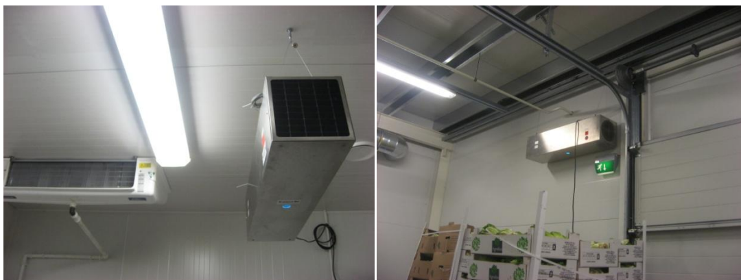
Kuva 25. UV-C ilmandesinfiointilaitteet asennettuina paikoilleen välivarastoihin A ja B.
